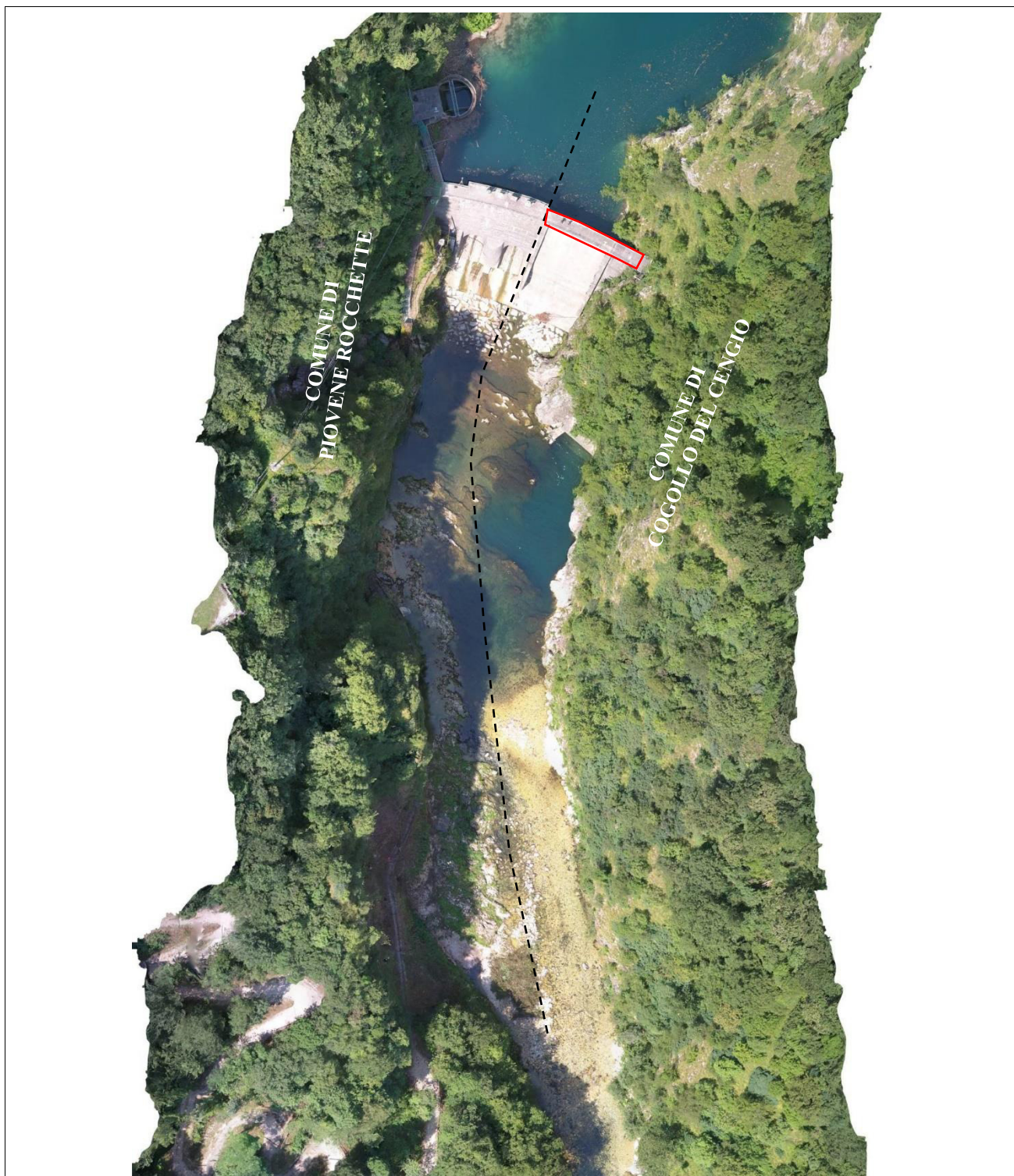
Ortofoto della diga con evidenziata l'area di intervento nel comune di Cogollo del Cengio
