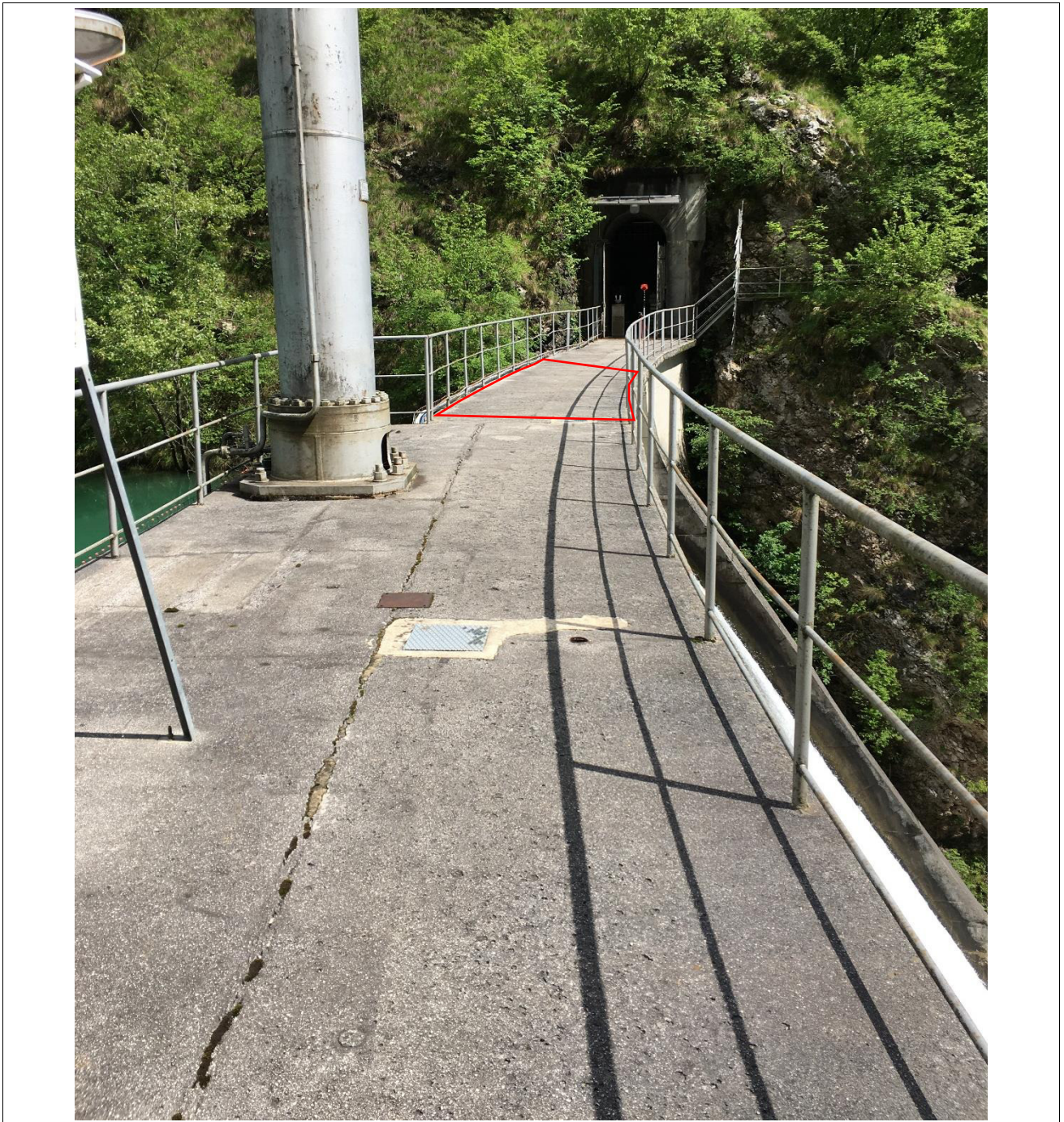
Coronamento della diga di Ieda con evidenziata la passerella oggetto dell'intervento di sostituzione
