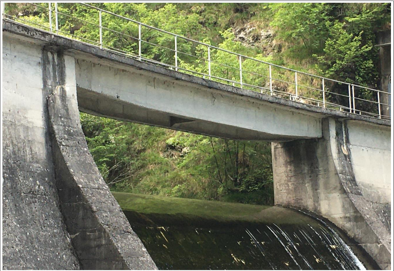
Particolare della passerella oggetto dell'intervento di sostituzione
