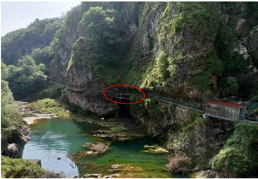
Vista del percorso di accesso alla diga con evidenziata la passerella oggetto di intervento
