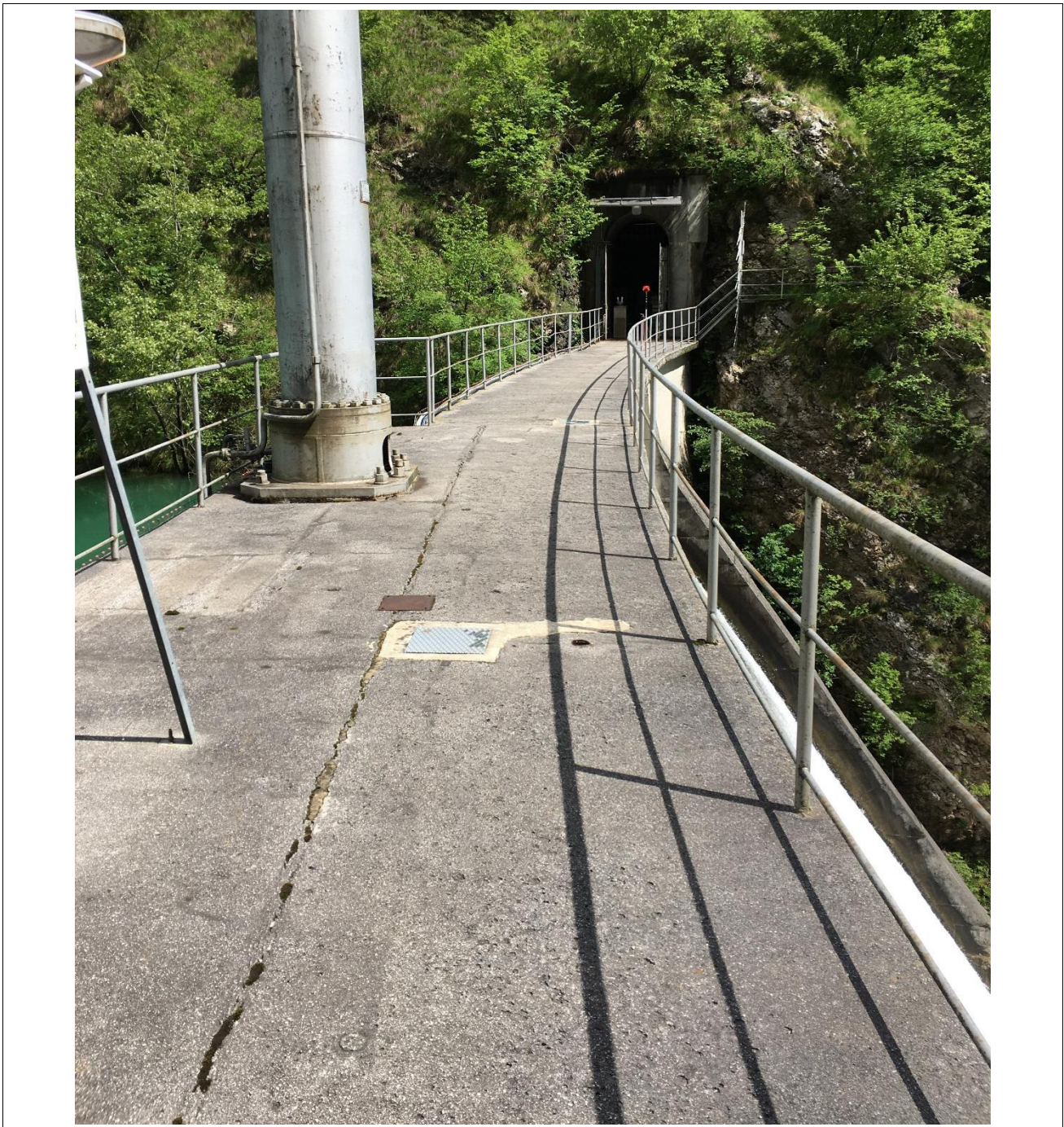
Coronamento della diga di Leda
