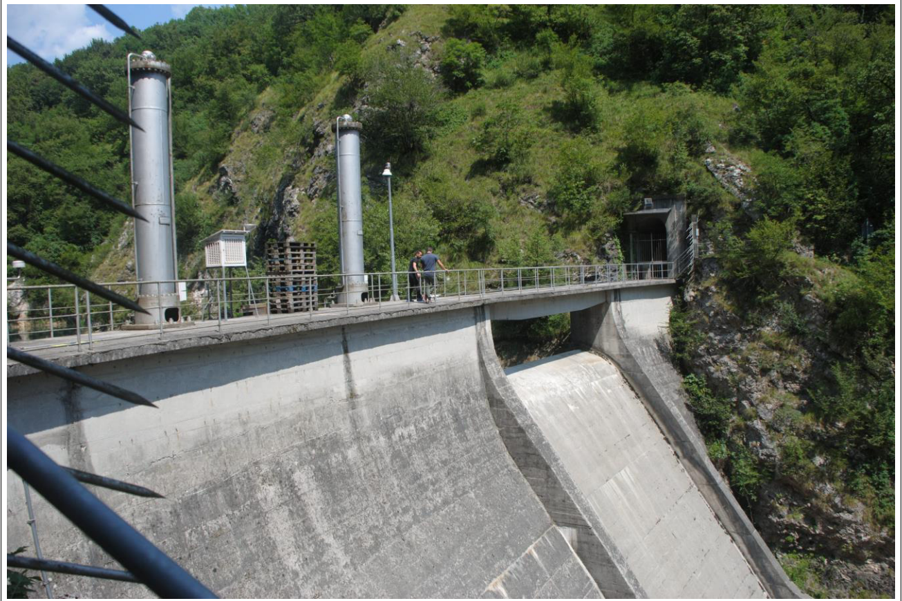
Coronamento della diga di Leda
