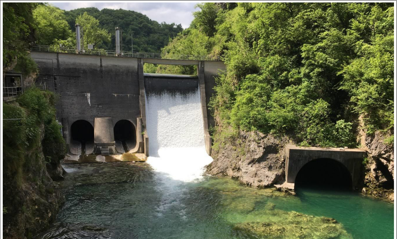
Vista da valle della diga di Leda
