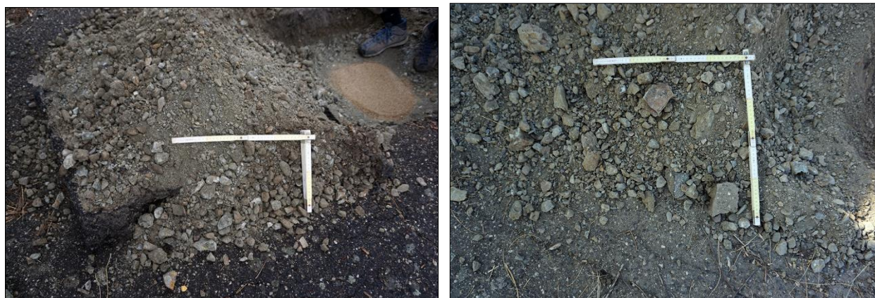
Figura 7 – Strato di fondazione rilevato sui punti indagati con le prove di carico su piastra in prossimità del sondaggio S5 (foto sinistra) e nel sondaggio S1.
