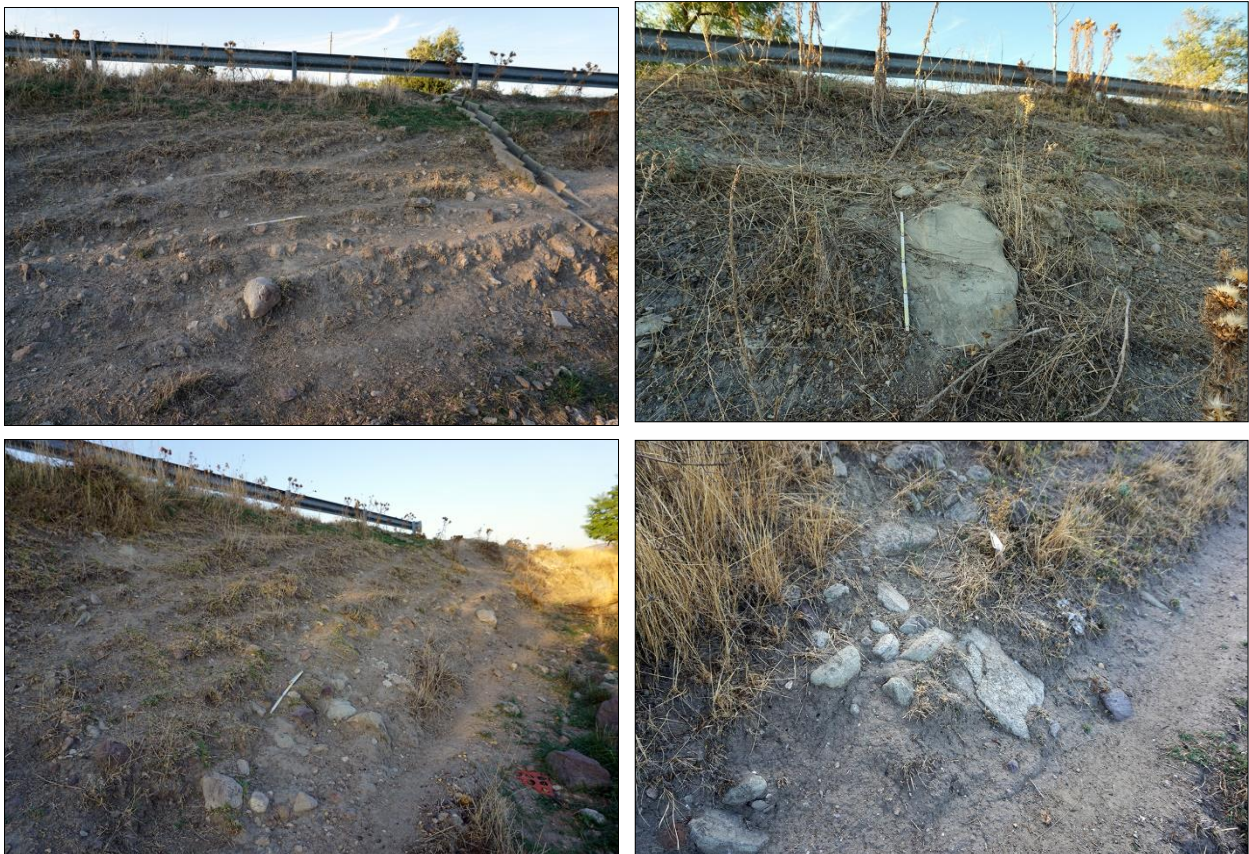
Figura 8 – Panoramiche del corpo del rilevato riprese in prossimità dei punti di indagine.
