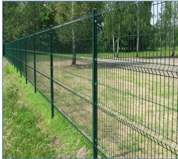
Figura 3.9. Esempio di recinzione perimetrale con pali ad infissione nel terreno senza utilizzo di plinti in cemento.
