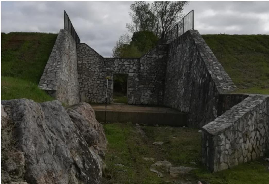
**Figura 8. Cassa Torrente Scarna: bocca tarata d'uscita e gaveta**
