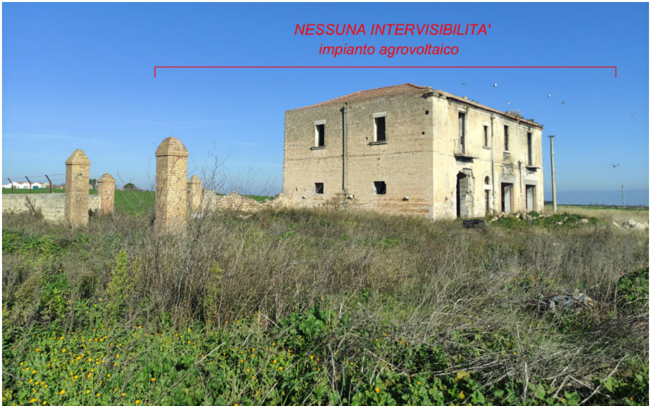
Punto di presa dalla Masseria S. Antonio – Stato di progetto. L'impianto non risulta visibile.
