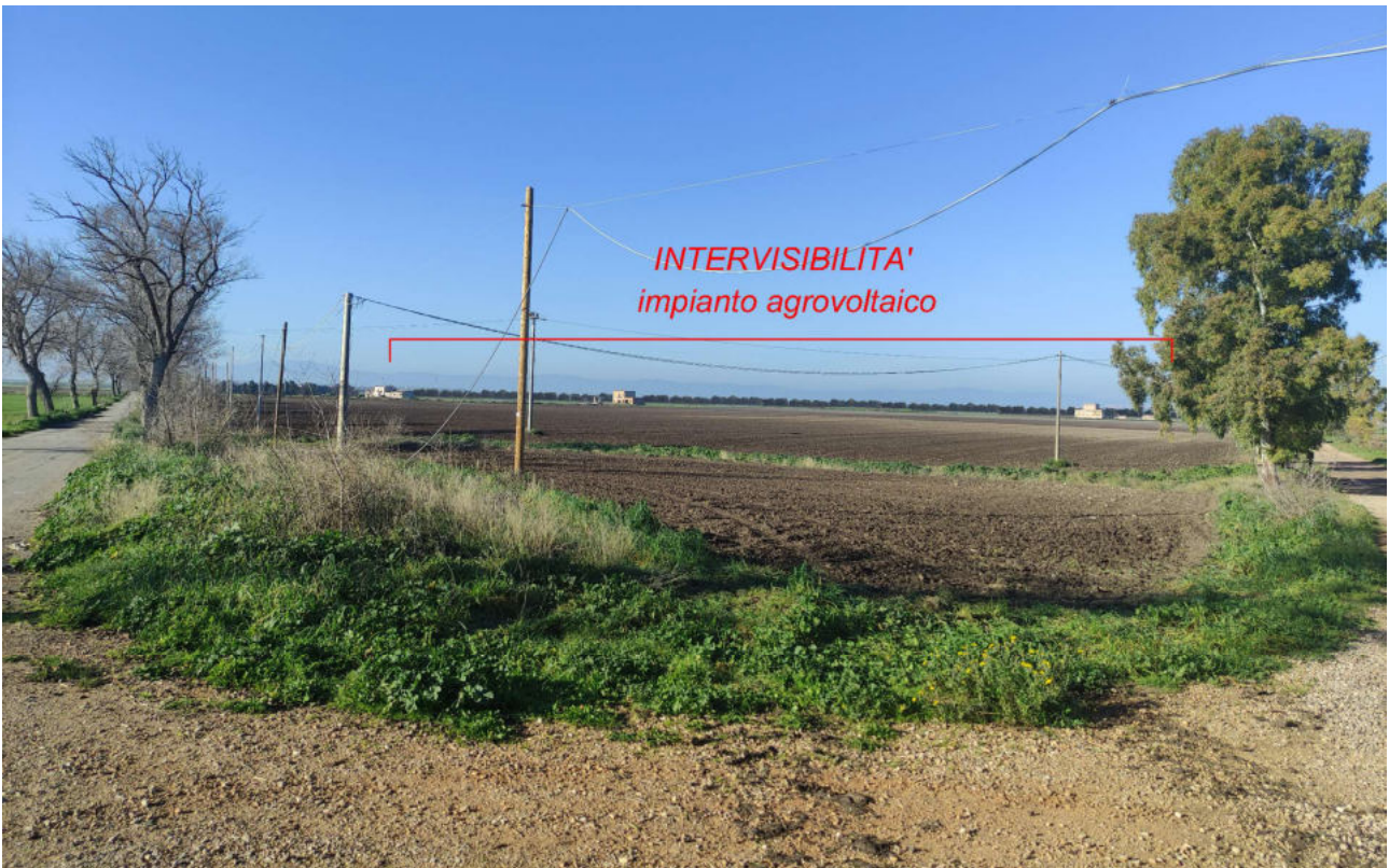
Punto di presa n. 1 dalla strada SP 17 – Stato di progetto. L'impianto risulta poco visibile; inoltre risulta visibile perlopiù la fascia arborea di mitigazione esterna alle aree recintate.
