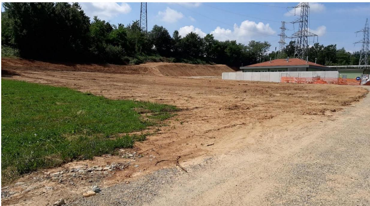
*Fig. 3: Riutilizzo dello scotico nell'ambito della realizzazione della Stazione Elettrica*
