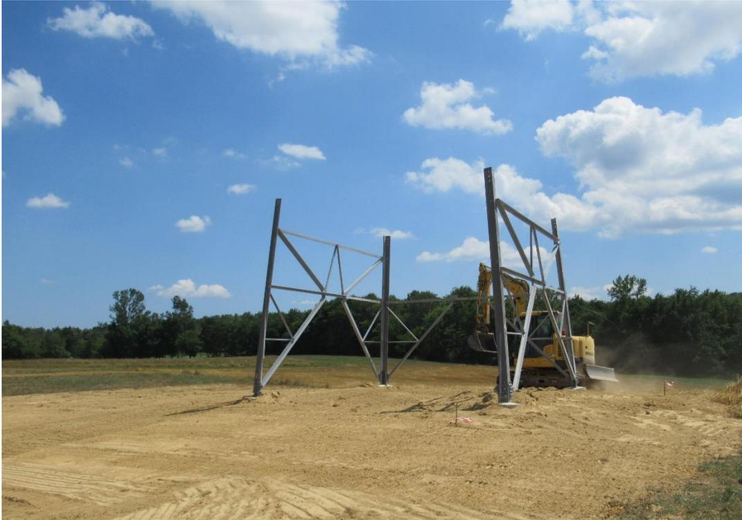
*Fig. 4: Riutilizzo dello scotico nell'ambito della realizzazione del sostegno p.12*
