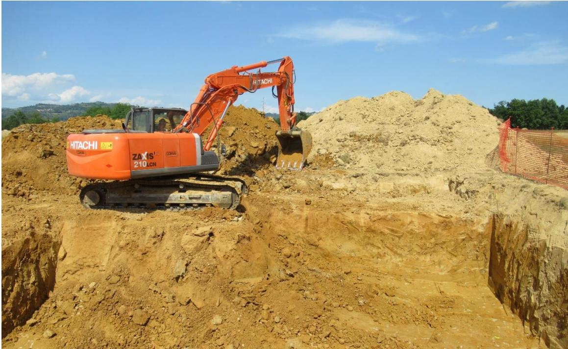
*Fig. 2: Separazione dello scotico nell'ambito della realizzazione sostegno p.12*
