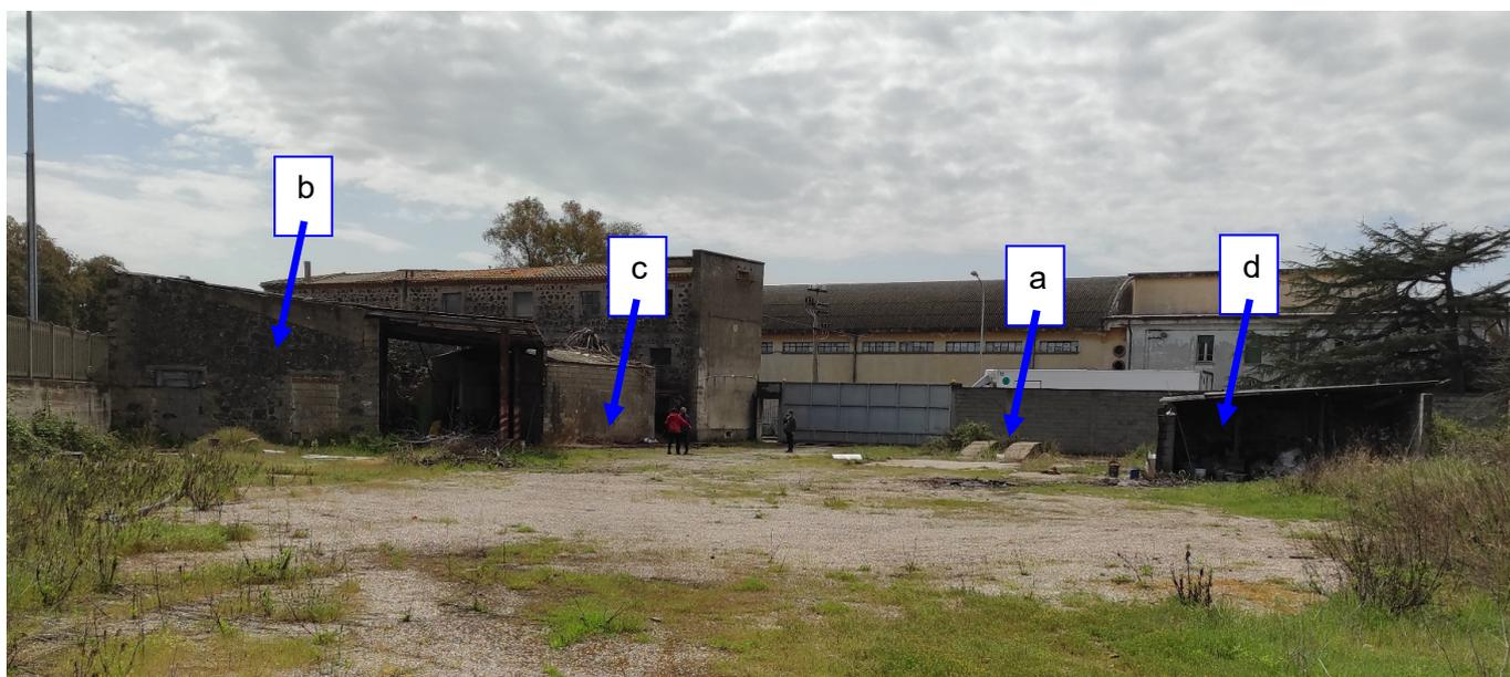
Si evidenzia che le tettoie dei fabbricati c e d sono costituite da lastre in fibrocemento con potenziale contenuto di amianto, per complessivi 160 mq. Nelle successive fasi progettuali
