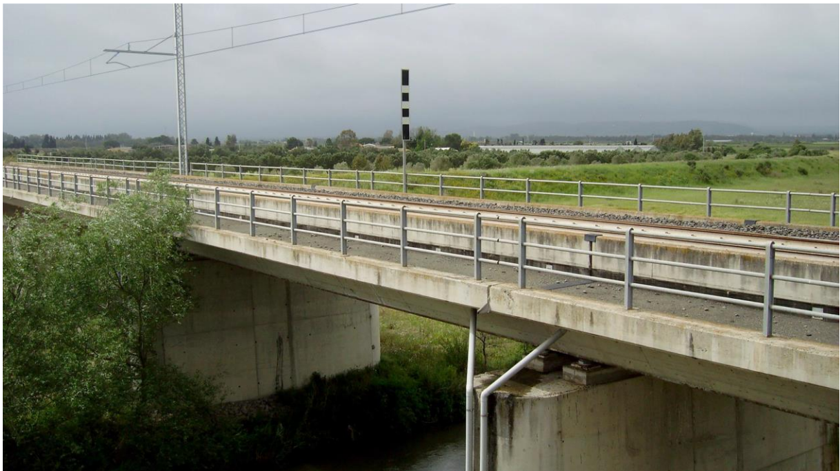
Figura 49 Viadotto ante operam e post operam
