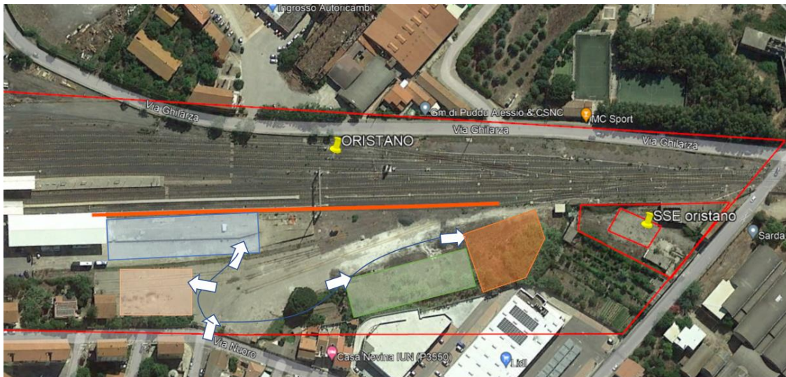
Vista aerea di C0.03 (GoogleEarth)
