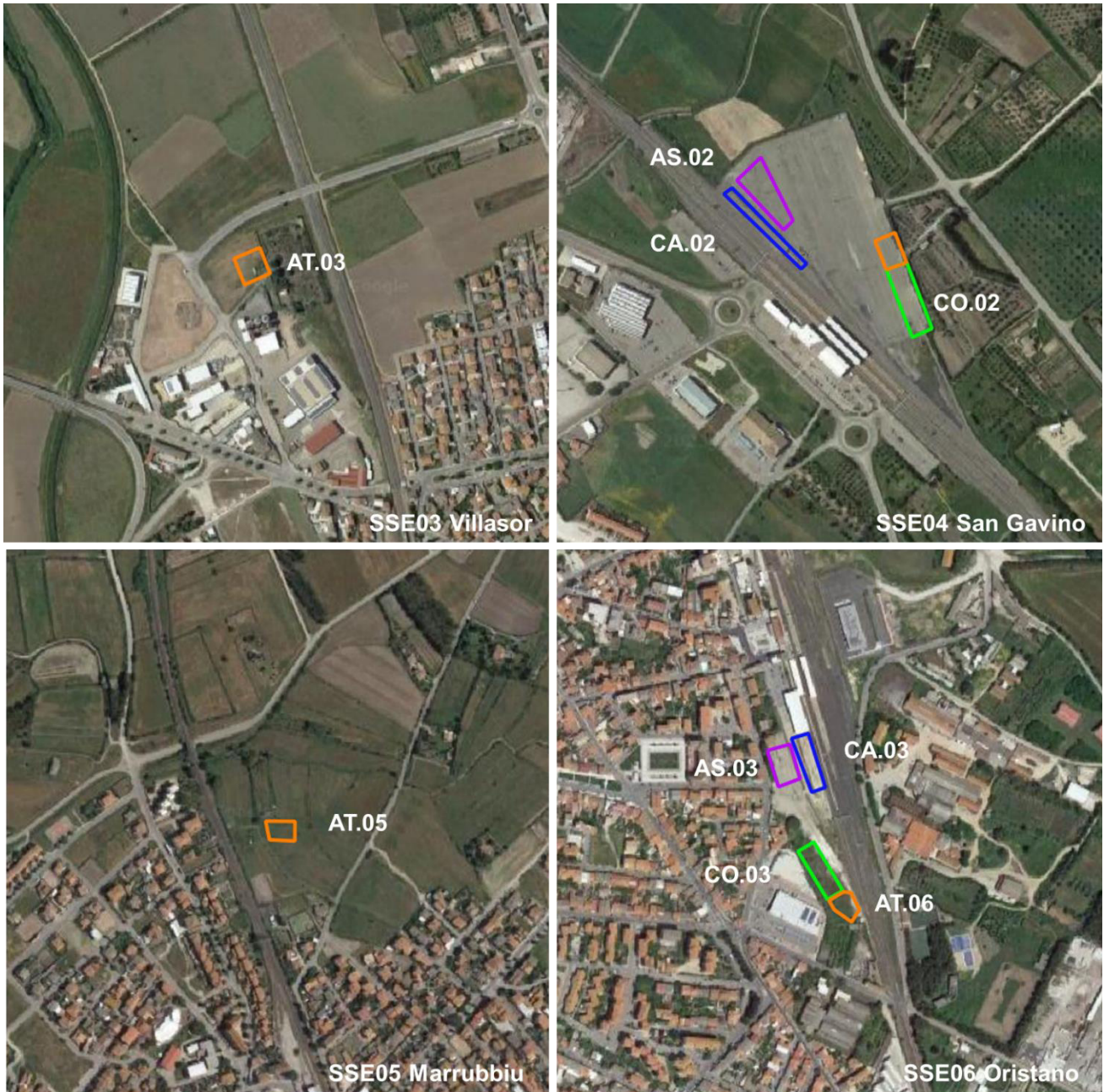
Figura 2-4 Aree di cantiere fisso: Contesto localizzativo
