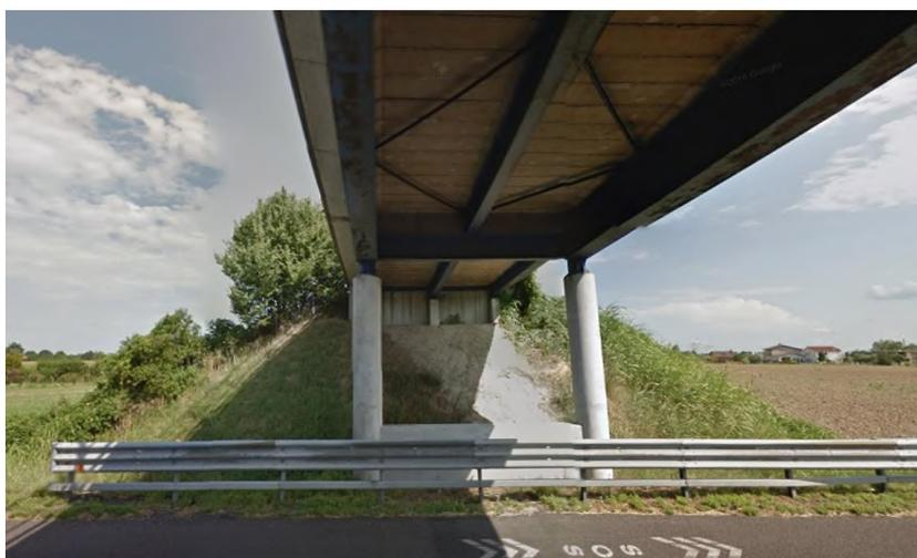
Figura 3-3 Vista spalle e intradosso impalcato
