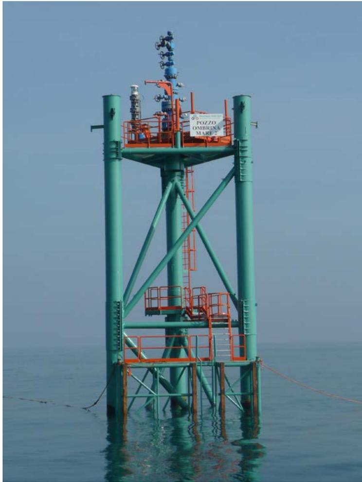
Figura 2.2.1.a – Struttura a traliccio con testa pozzo Ombrina Mare 2 Dir
