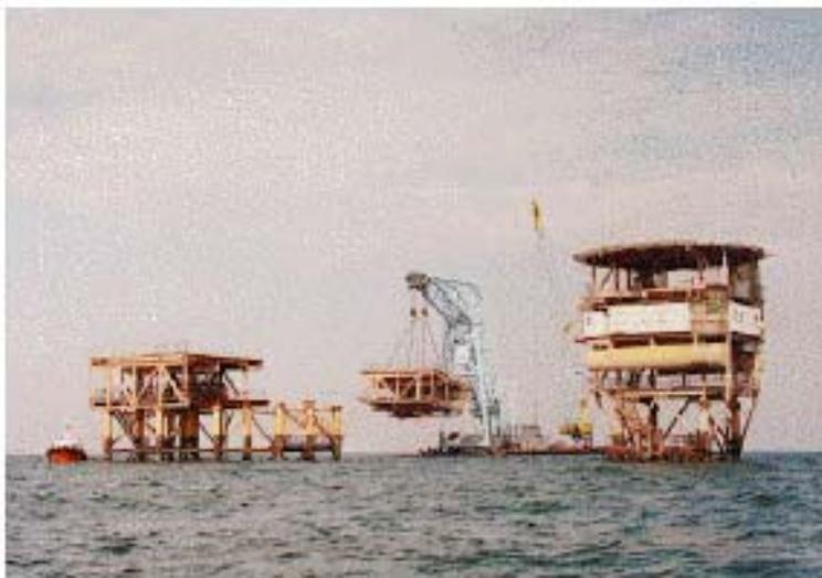
Figura 2.8.c – Sollevamento di un deck e di un jacket
