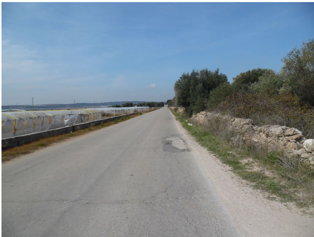
Figura 4: Punto 026 - Vista in direzione CP_TAR- fine viabilità sterrata e immissione su SP74
