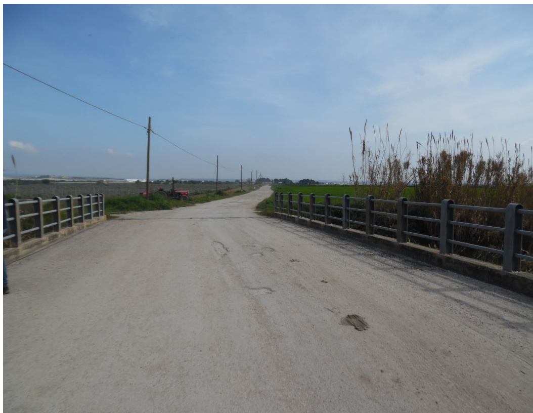
Figura 7: Punto 029 - Vista in direzione impianto FV
