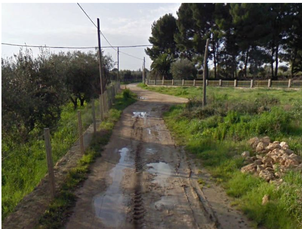
Figura 13: Punto 037 - Vista in direzione CP_TAR- strada vicinale sterrata
