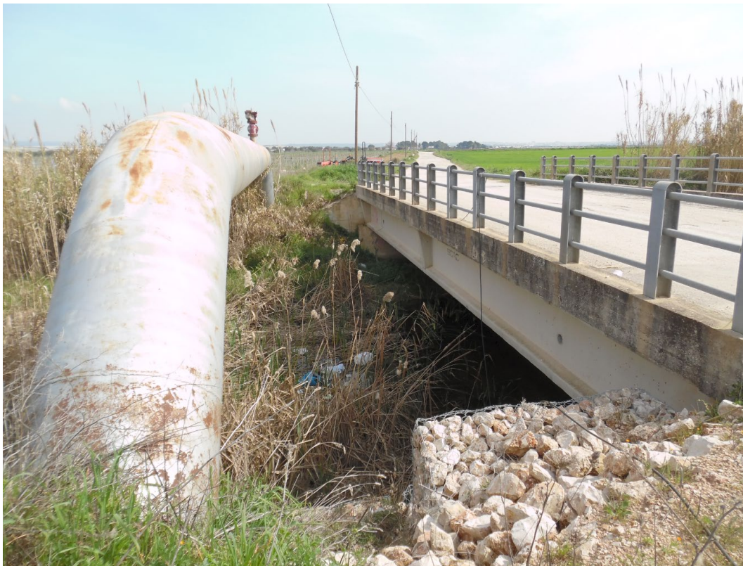
Figura 10: Punto 029 - Ponte, lato nord - presenza condotta
