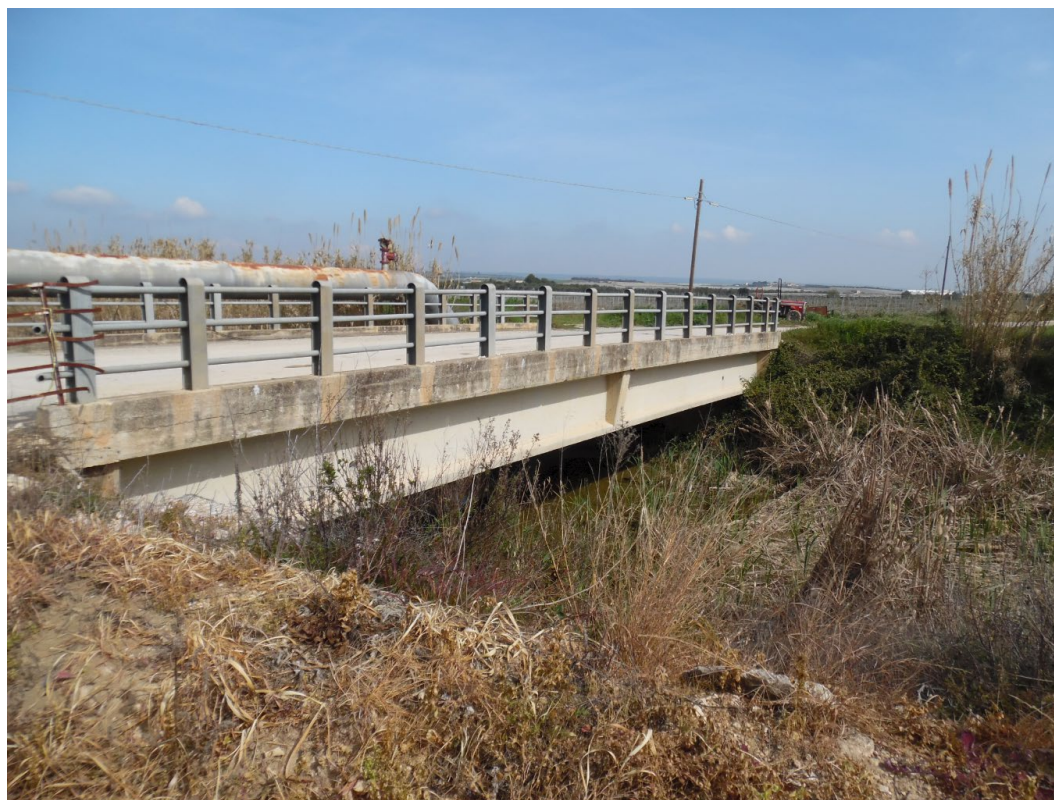
Figura 9: Punto 029 - Ponte, lato sud
