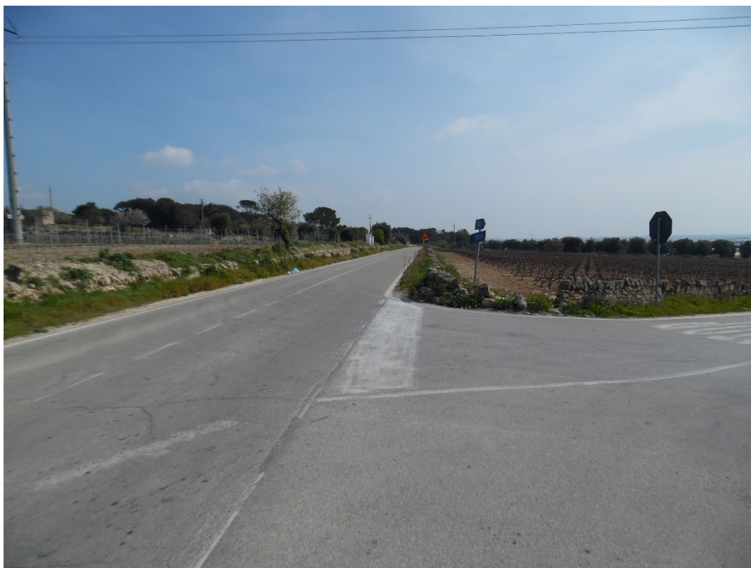
Figura 5: Punto 027 - Vista verso impianto- incrocio tra SP74 e SP80
