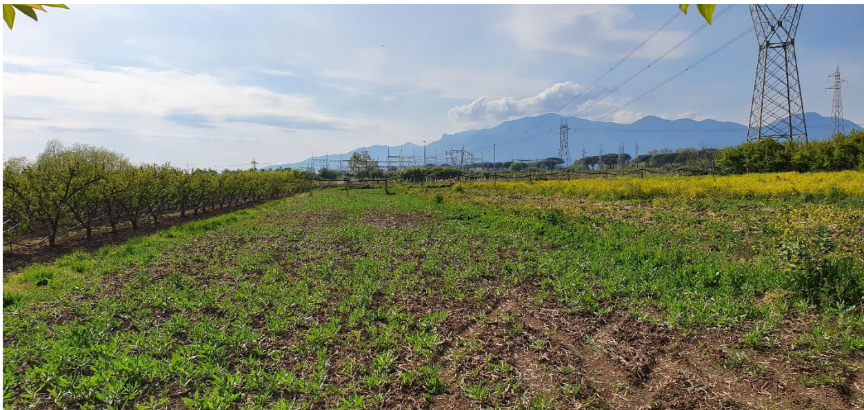
Foto 2 – Aspetti vegetazionali dell’area in prossimità della stazione elettrica – seminativo
