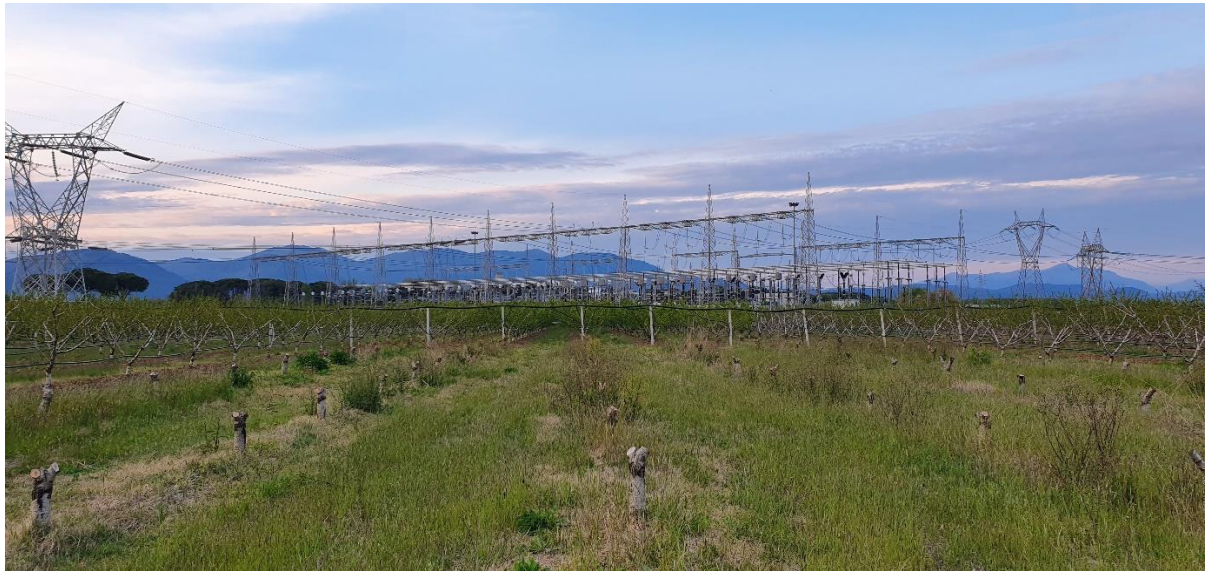
Foto 1 – Aspetti vegetazionali dell’area di intervento in prossimità della stazione elettrica – frutteto capitozzato a fine ciclo produttivo
