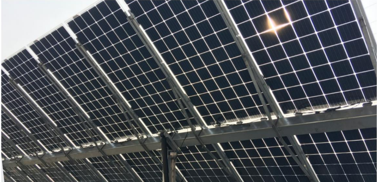
Figura 2.1: Esempio di Tracker mono-assiale
