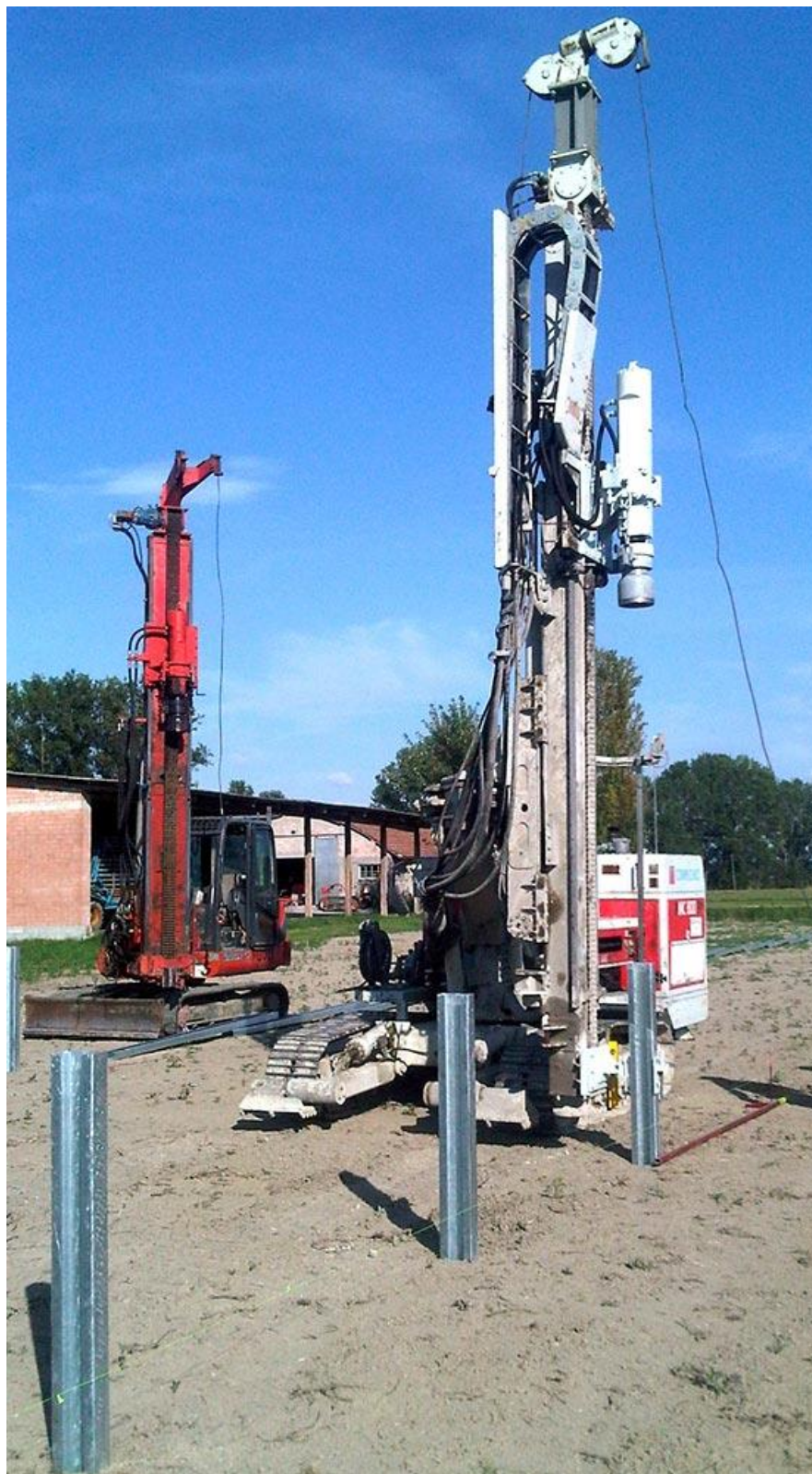
Figura 2.2: Esempio di Macchina Operatrice Battipalo per l'infissione dei pali di sostegno dei Tracker
