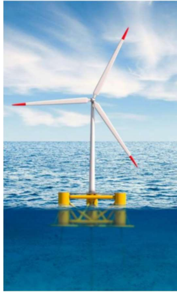
Figura 2.3 – Piattaforma di tipo semisubmersibile.
