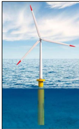
Figura 2.2 – Piattaforma di tipo spar.
