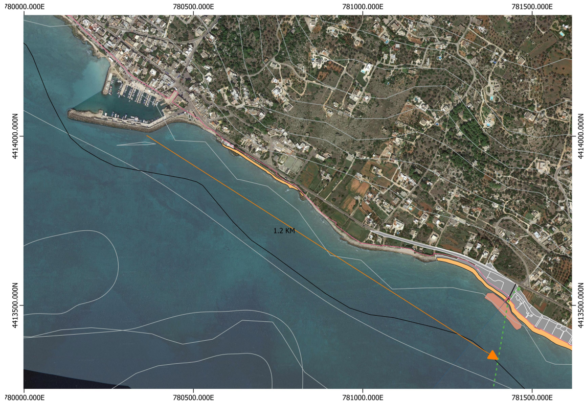
Figura 13: Presenza del porto di Torre Vado nell'area vasta interessata dal cavidotto marino. Si è
