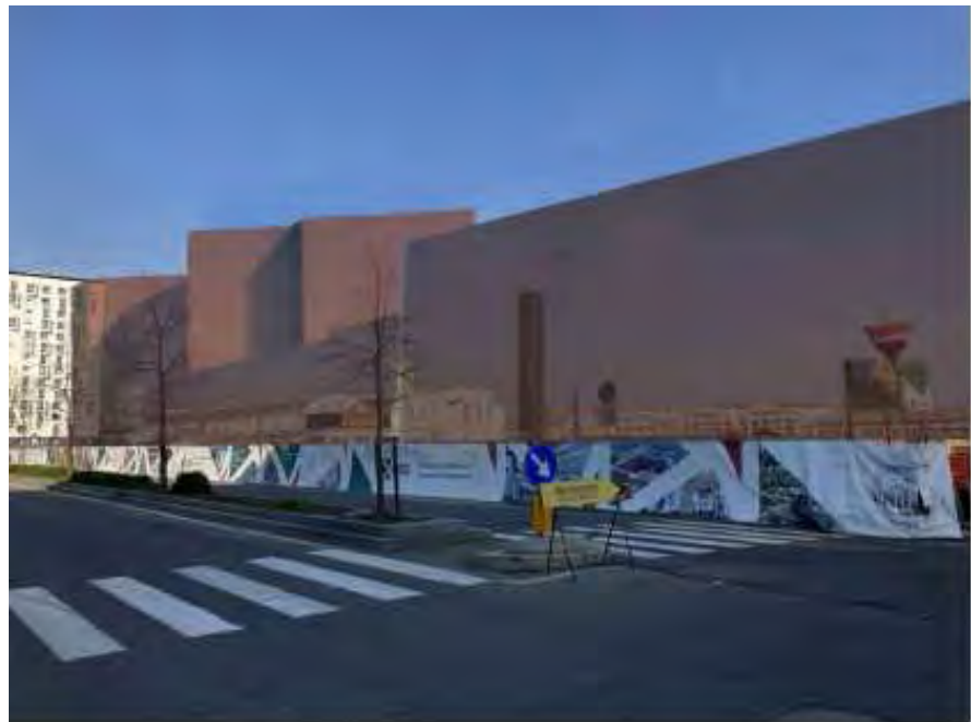
Figura 31 – Vista da via dell'innovazione con l'ingombro del nuovo ampliamento dell'università (punto 9)
