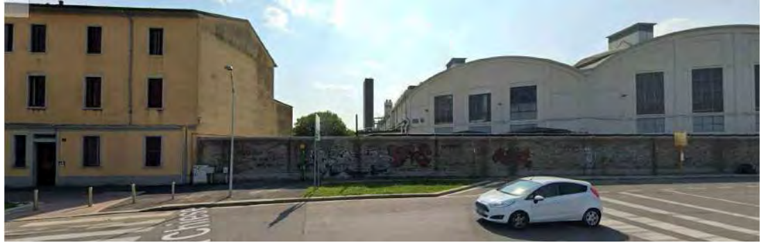
Figura 28 – Vista da via Chiese, ingresso Hangar Pirelli (punto 1)
