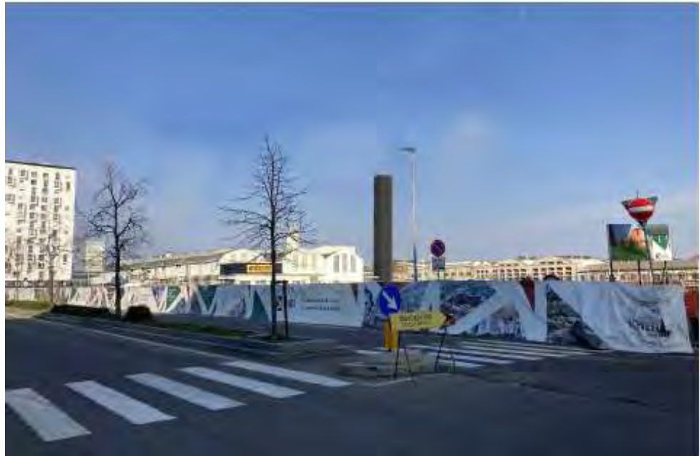
Figura 36 – Vista da via dell'Innovazione, senza l'ingombro del nuovo edificio previsto dall'Università (punto 9)
