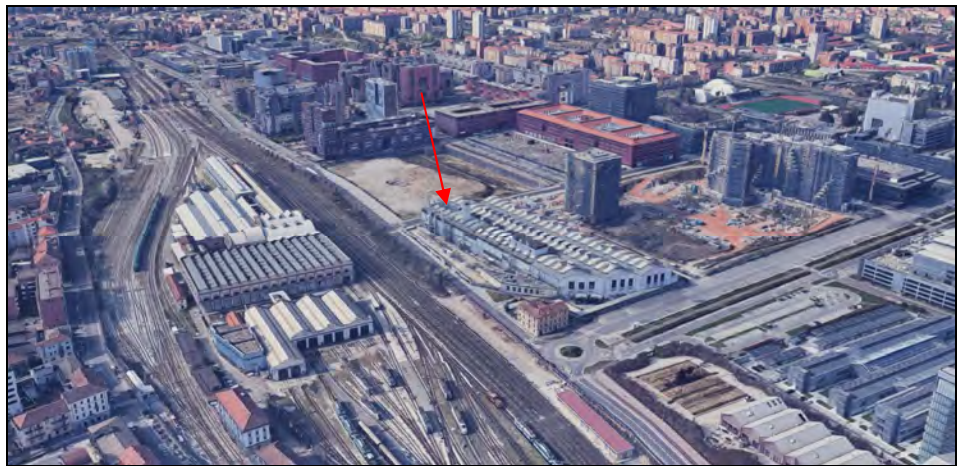
Figura 2 – Localizzazione dell'area: vista aerea
