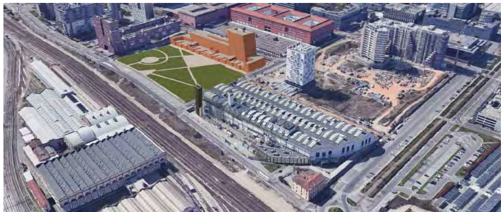
Figura 27 – vista aerea del nuovo camino
