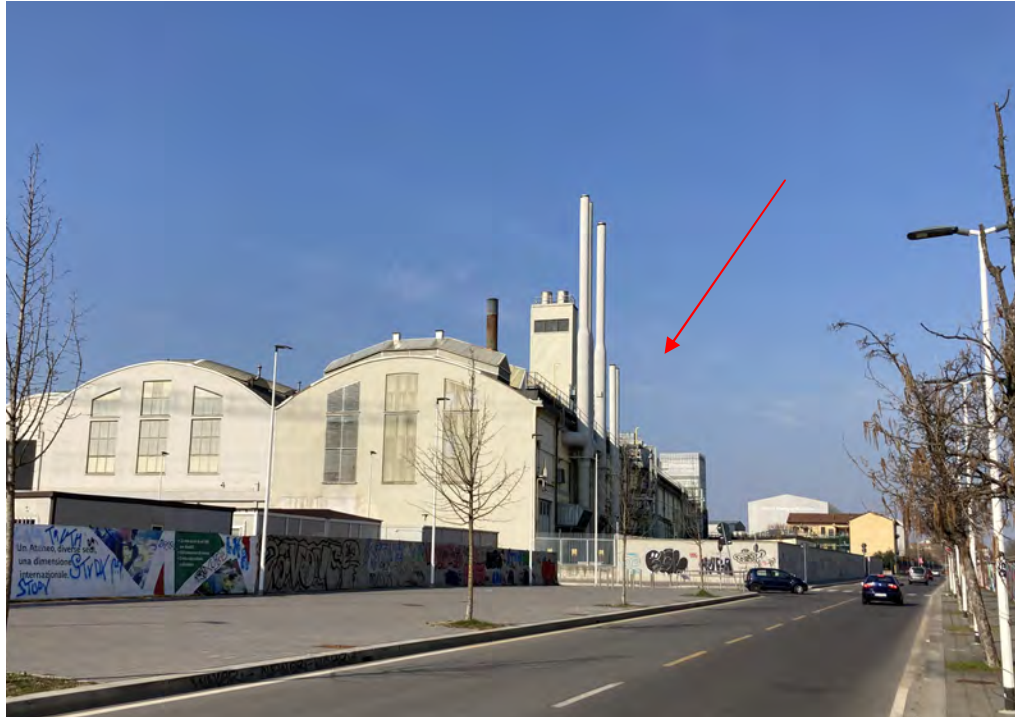
vista 2 Da via Sesto San Giovanni, in direzione Sesto San Giovanni
