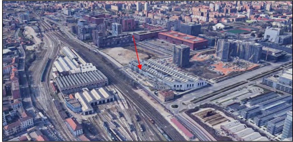
Figura 2 – Localizzazione dell'area: vista aerea
