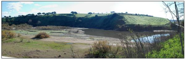
Per il Fiume Enas è auspicabile una generalizzata risagomatura dell'alveo in buona parte occluso dalla presenza di vari materiali prevalentemente di origine alluvionale ma anche di natura antropica legati alla costruzione dell'attuale viadotto.
