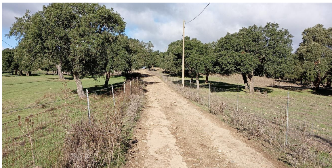
Figura 5.23 – Viabilità in adeguamento di accesso alla postazione WTG014
