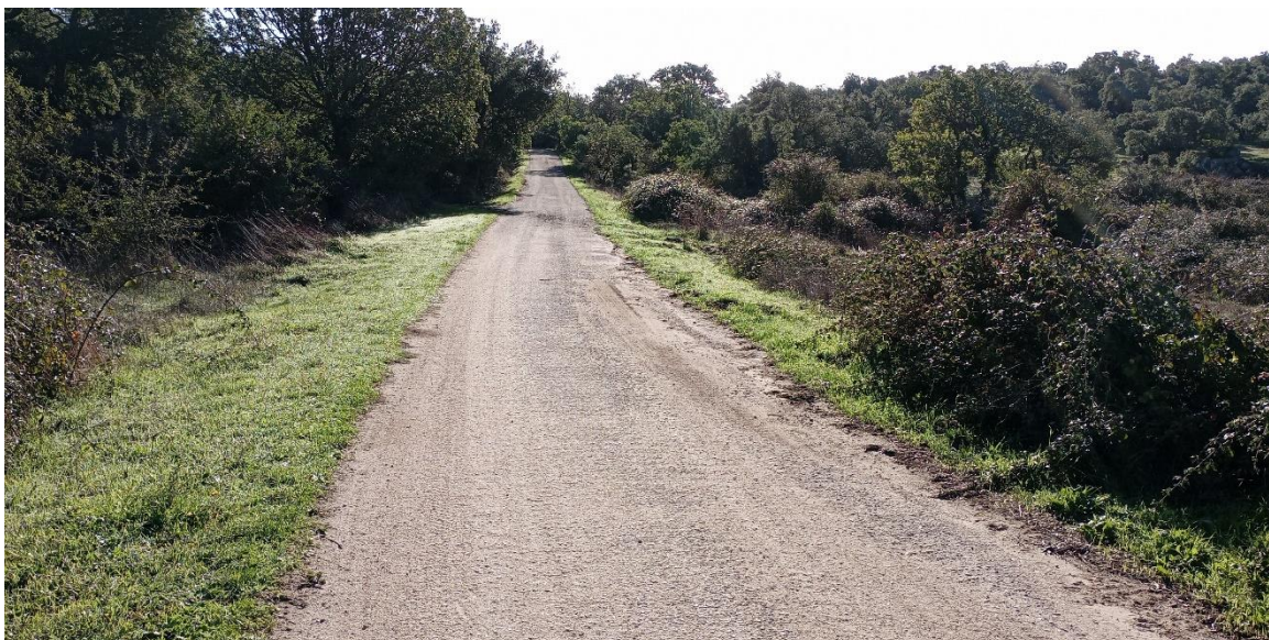
Figura 5.9 – Esistente viabilità in adeguamento lungo l'accesso alle postazioni WTG002, WTG003, WTG004 E WTG006 facente parte della viabilità di progetto
