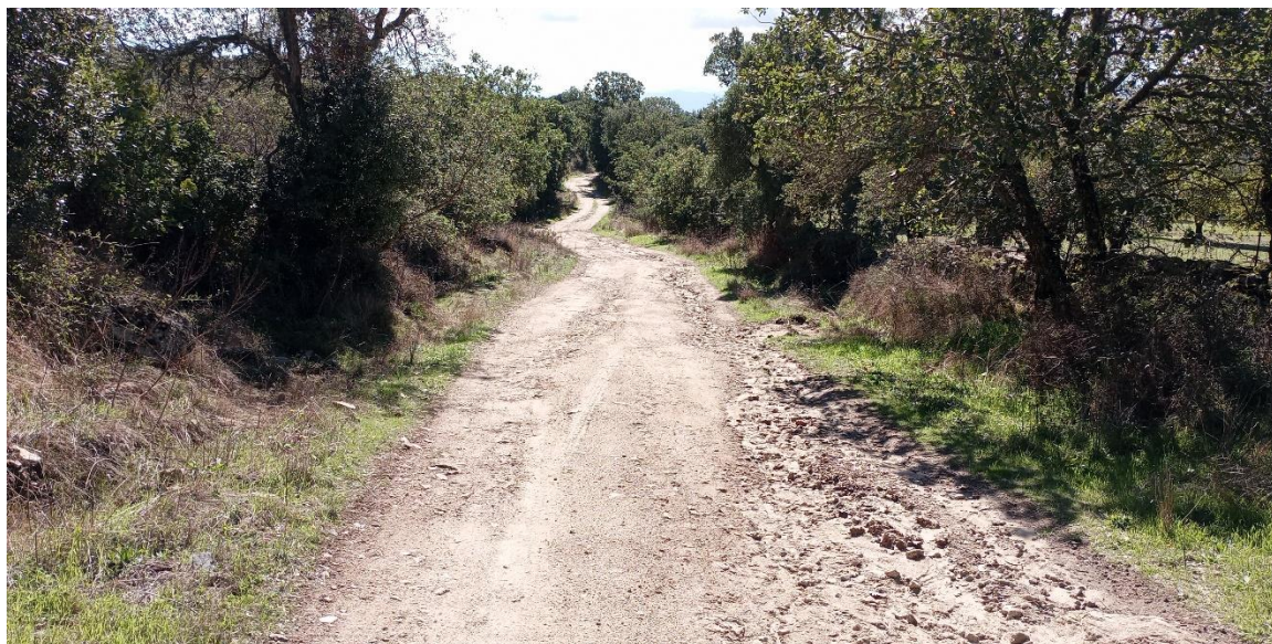
Figura 5.14 – Viabilità in adeguamento di accesso alle postazioni WTG007, WTG008, WTG009 e WTG010
