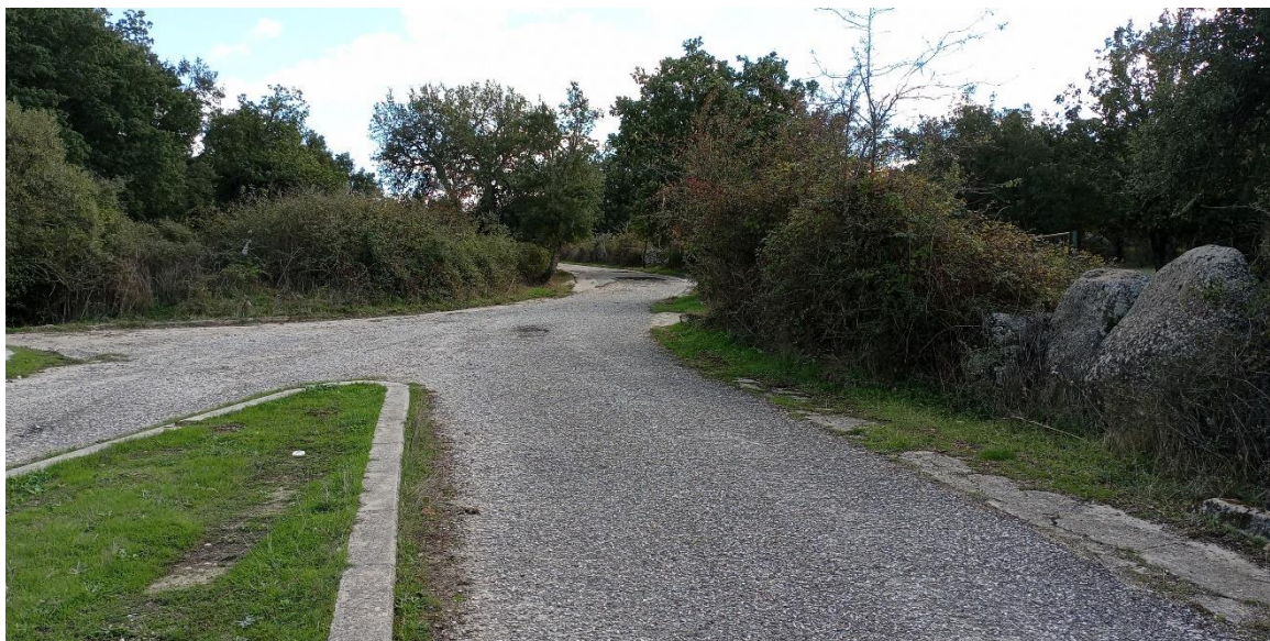
Figura 5.1 – Inizio dell’esistente viabilità da adeguare lungo la SP41 facente parte della viabilità di progetto.
