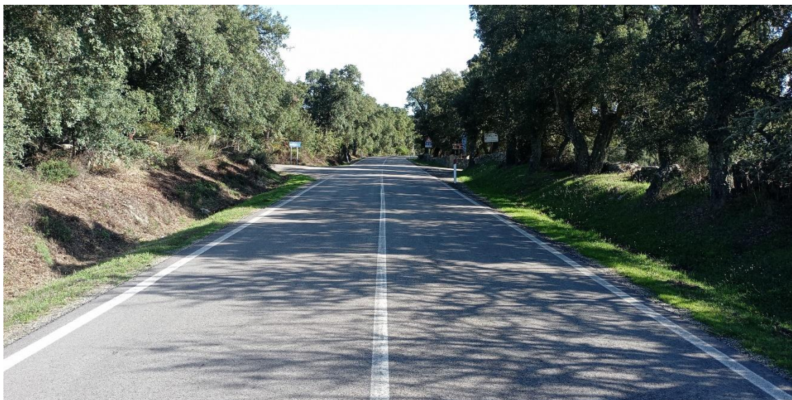
Figura 5.3 – Raccordo tra la Sp41 e l'area di manovra per accesso alle WTG013, WTG014 e WTG015. Direzione di scatto NE
