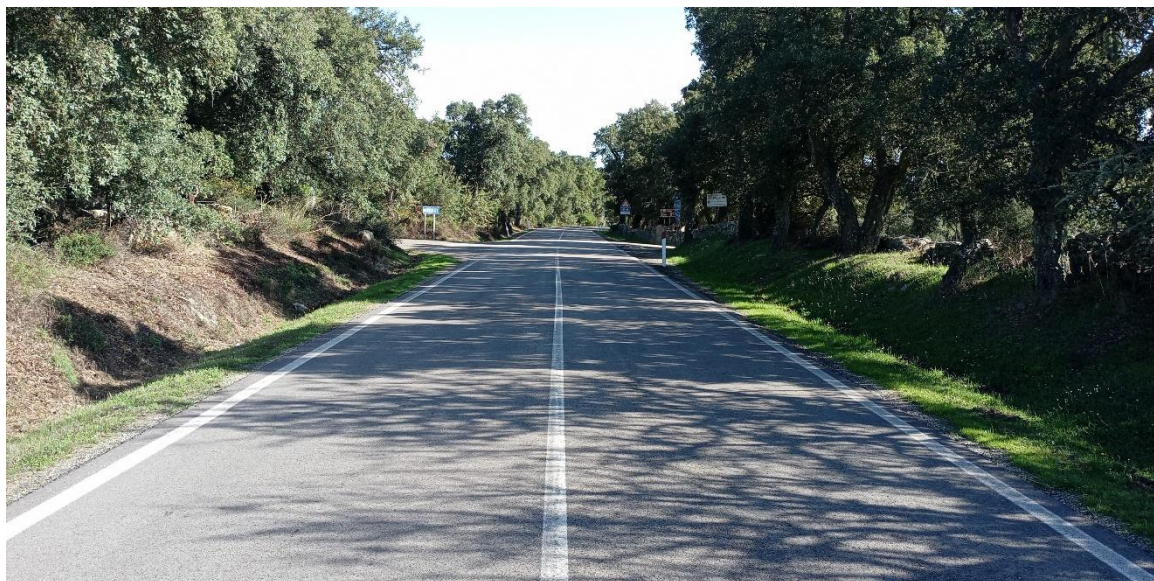
Figura 5.6 – Raccordo tra la Sp41 e l'area di manovra per accesso alle WTG013, WTG014 e WTG015. Direzione di scatto NE
