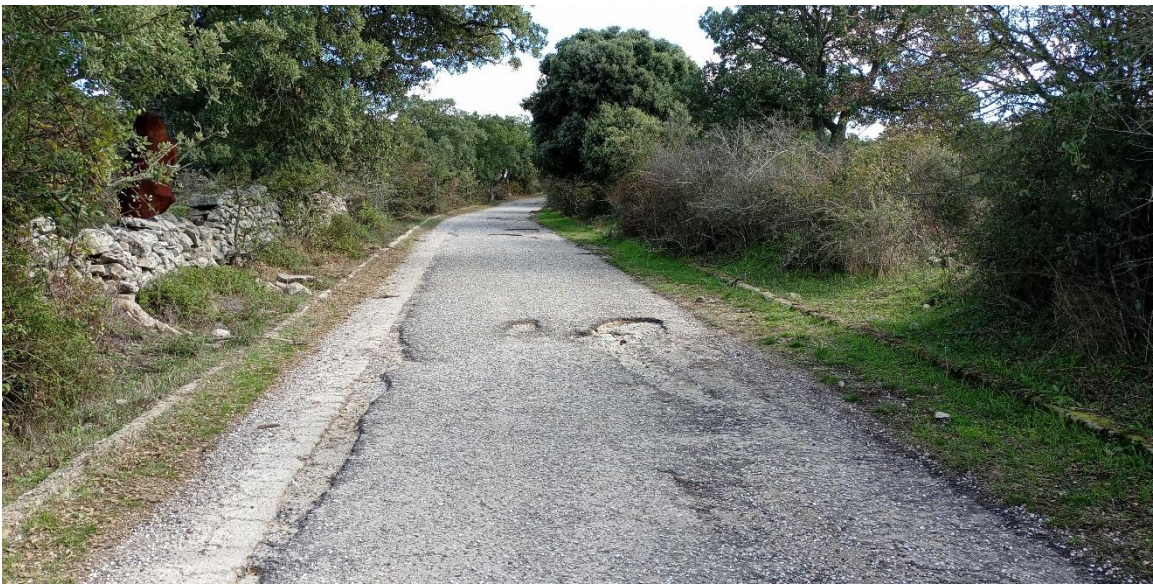
Figura 5.7 – Strada locale in adeguamento che collega alle postazioni WTG001 e WTG005
