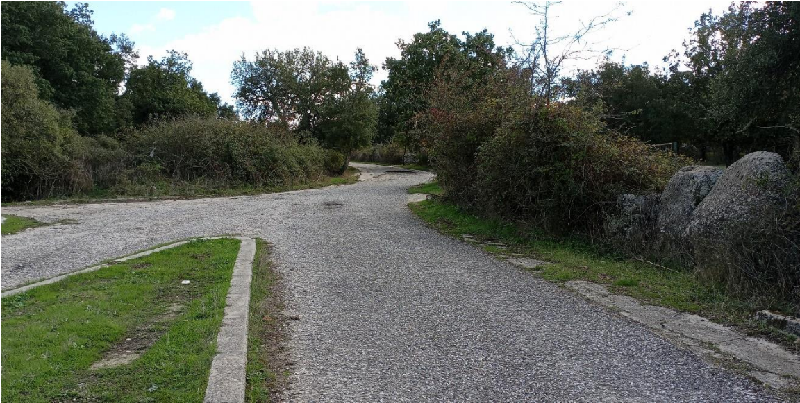
Figura 5.4 – Inizio dell'esistente viabilità da adeguare lungo la SP41 facente parte della viabilità di progetto
