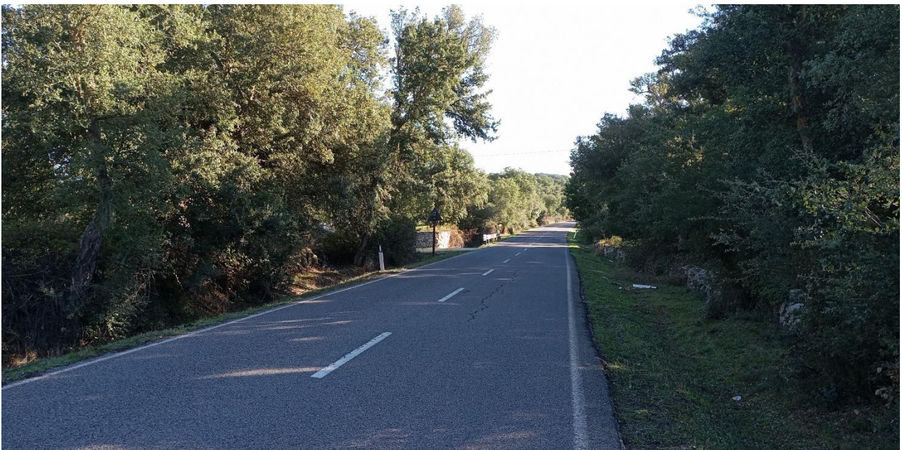
Figura 9.10 - Innesto della viabilità di penetrazione agraria sulla SS 389 che permette di raggiungere gli aerogeneratori WTG014 e WTG015
