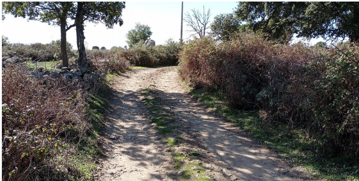
Figura 5.10 –Strada locale da adeguare lungo la viabilità di accesso alla postazione WTG001
