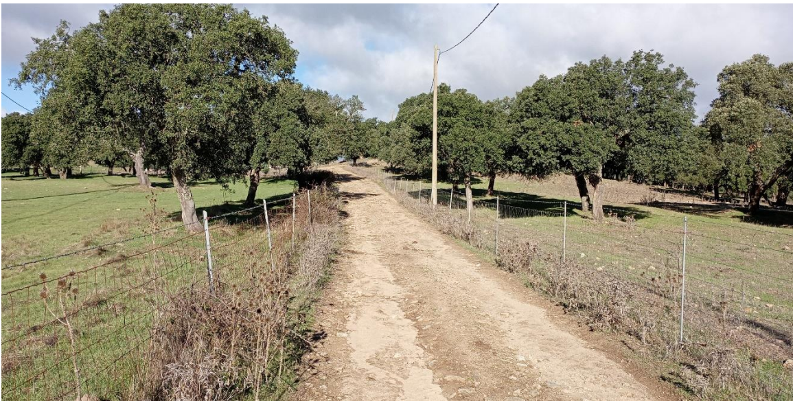
Figura 5.26 – Viabilità in adeguamento di accesso alla postazione WTG014
