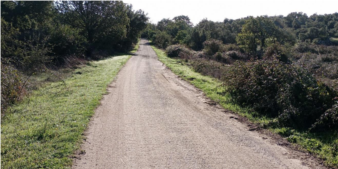
Figura 5.12 – Esistente viabilità in adeguamento lungo l'accesso alle postazioni WTG002, WTG003, WTG004 E WTG006 facente parte della viabilità di progetto
