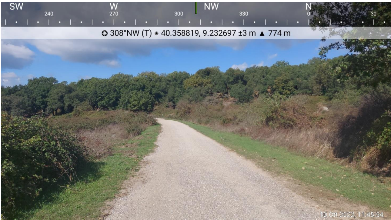
Figura 63 - Viabilità esistente da adeguare per il raggiungimento della WTG005 e 001
