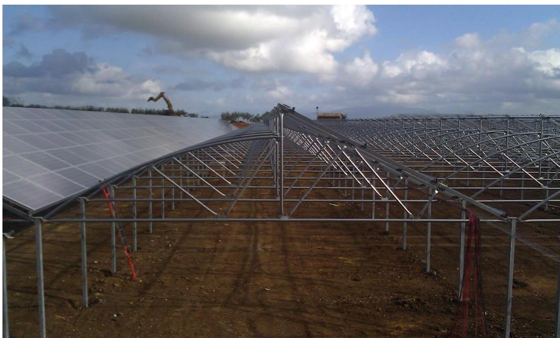
La **bulloneria** impiegata per l'assemblaggio degli elementi strutturali ha **classe di resistenza meccanica 8.8** ed è zincata.
