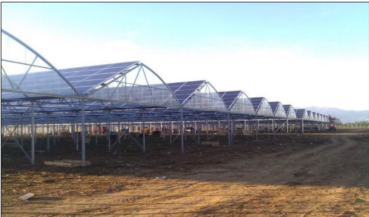
Figura 3 - Particolare di strutture serre
