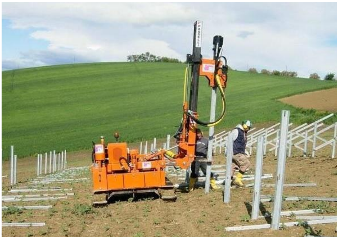
Figura 16. Macchina battipalo
