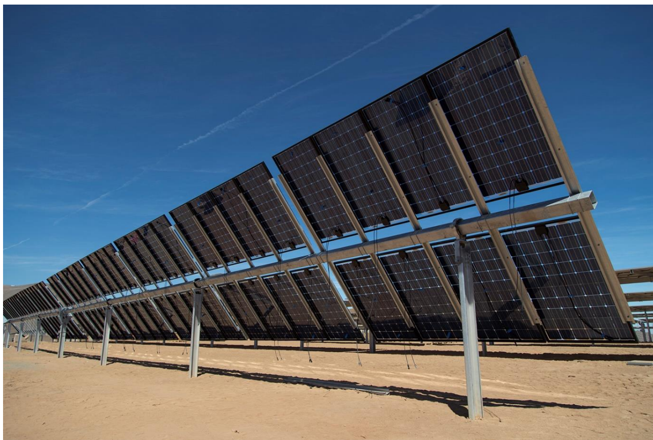
Figura 6. Particolari struttura di sostegno moduli
