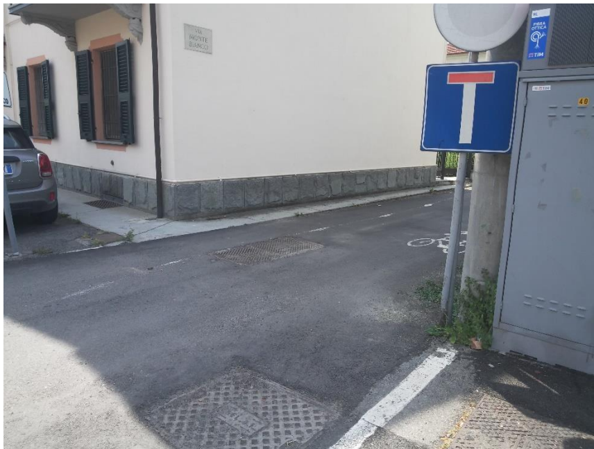
Figura 29. Deviazione che da Via Mazzini porta a Via Monte Bianco. Si notino i tombini presenti su ambo i lati della carreggiata stradale.
