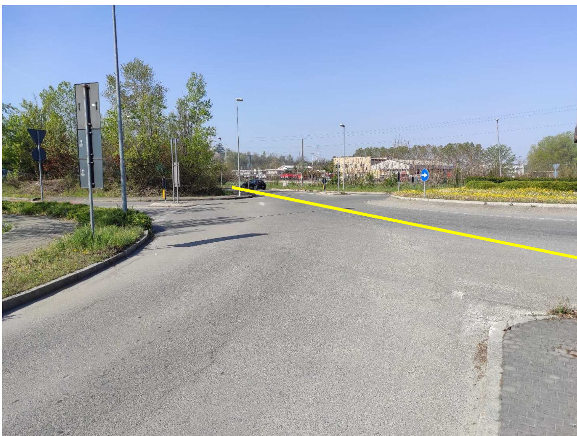
Figura 40. Incrocio Via delle Filande-Via Trattato di Bruxelles - Posa linea elettrica su strada asfaltata
