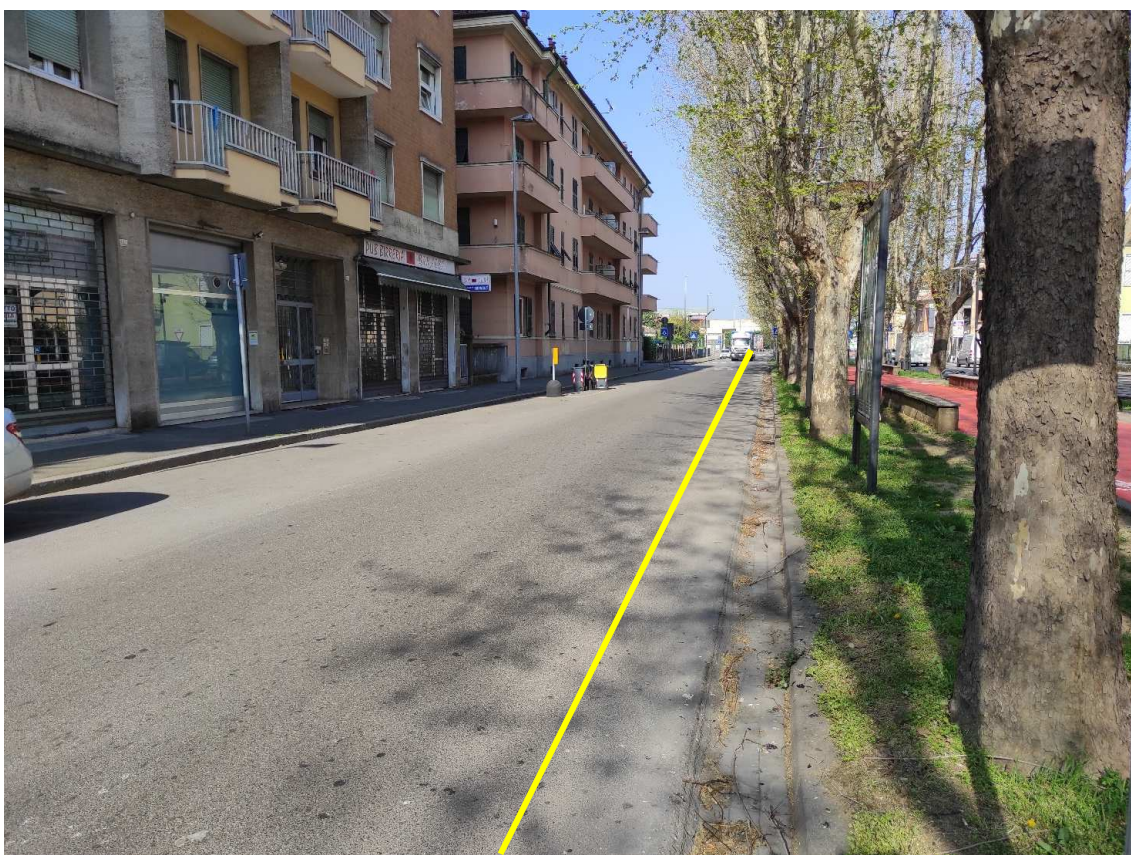
Figura 22. Viale della Rimembranza - Posa linea elettrica su strada asfaltata
