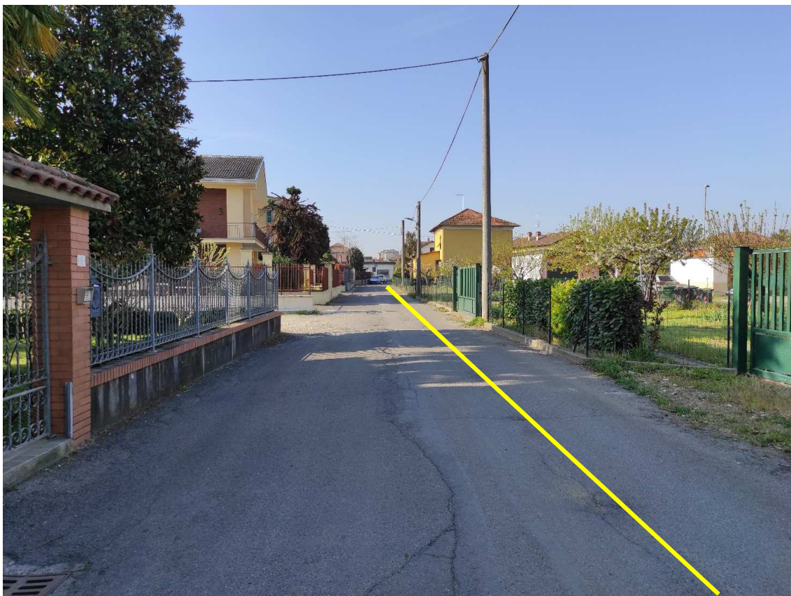
Figura 5. Strada della Pavese - Posa linea elettrica su strada asfaltata
