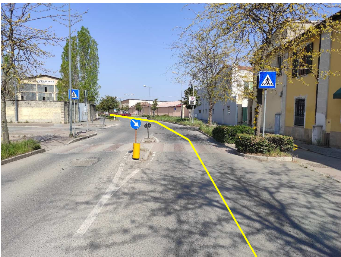
Figura 34. Via Nino Bixio - Posa linea elettrica su strada asfaltata
