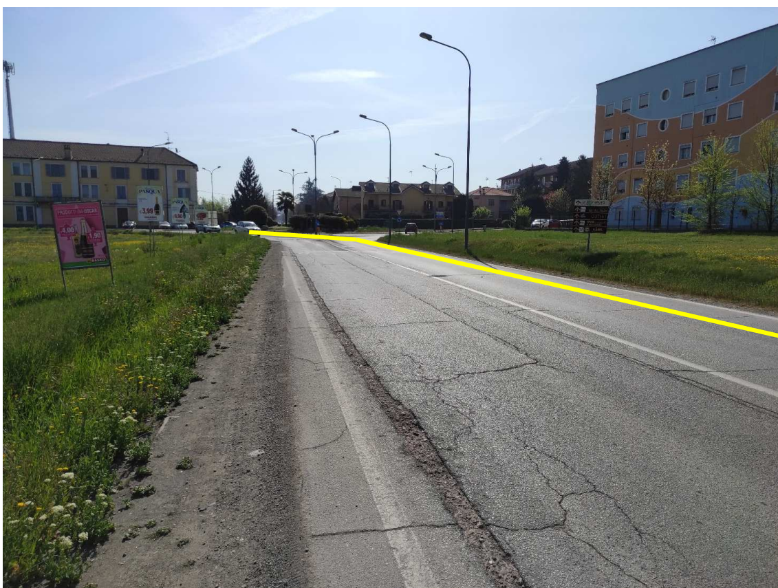
Figura 44. Strada del Turchino - Posa linea elettrica su strada asfaltata
