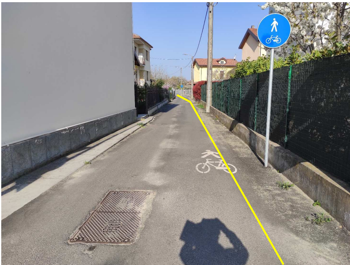
Figura 9. Via Monte Bianco - Posa linea elettrica su strada asfaltata
