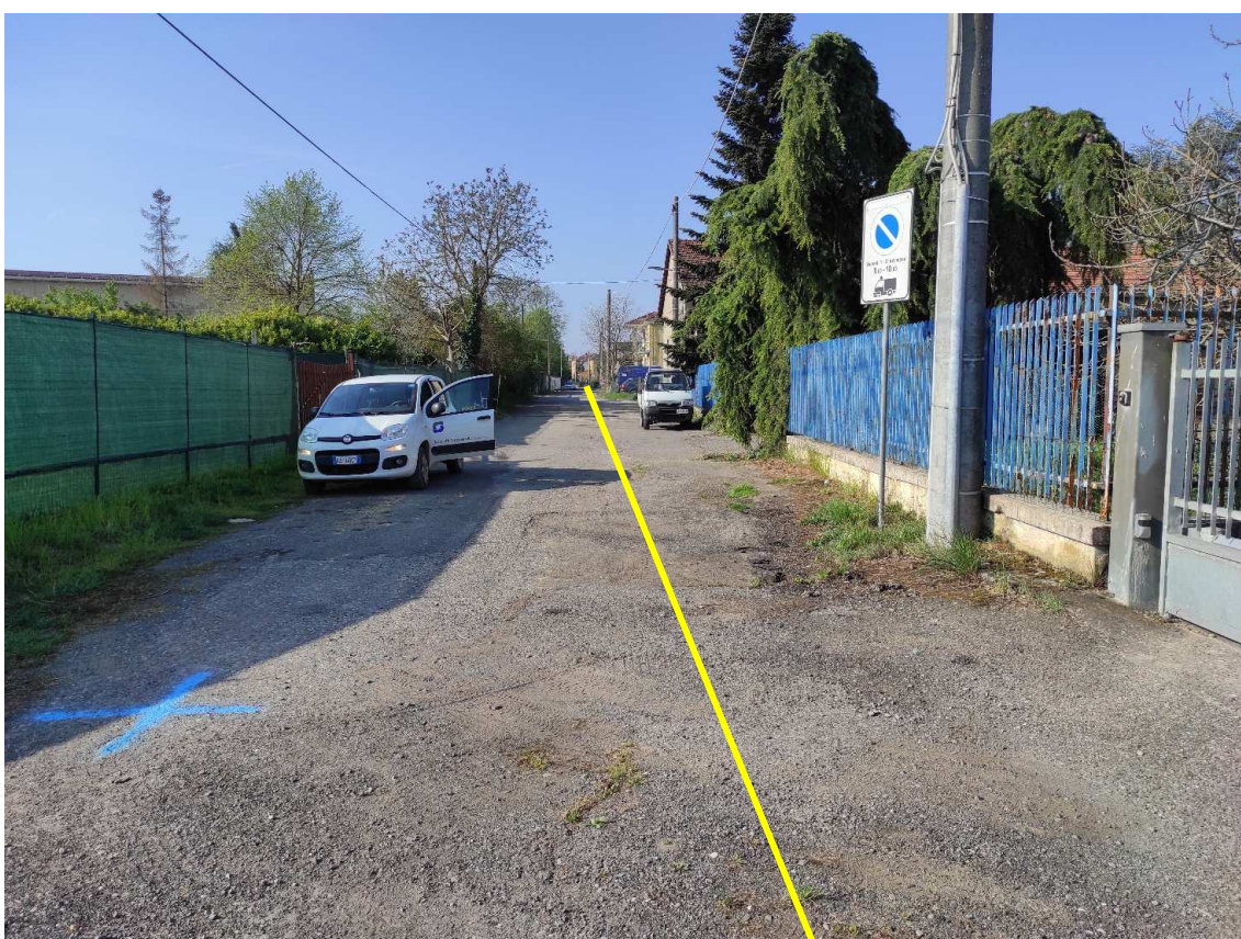
Figura 2. Strada della Pavese - Posa linea elettrica su strada asfaltata
