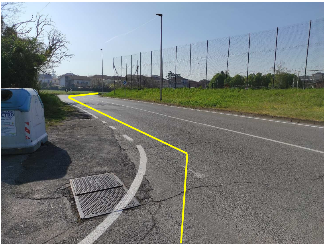
Figura 15. Via Pinan Cichero - Posa linea elettrica su strada asfaltata
