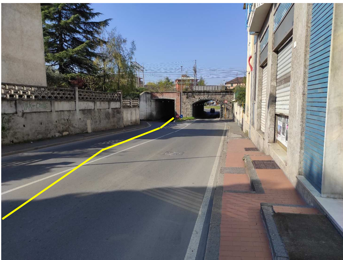
Figura 26. Via Francesco Crispi-Sottopasso Ferroviario - Posa linea elettrica su strada asfaltata
