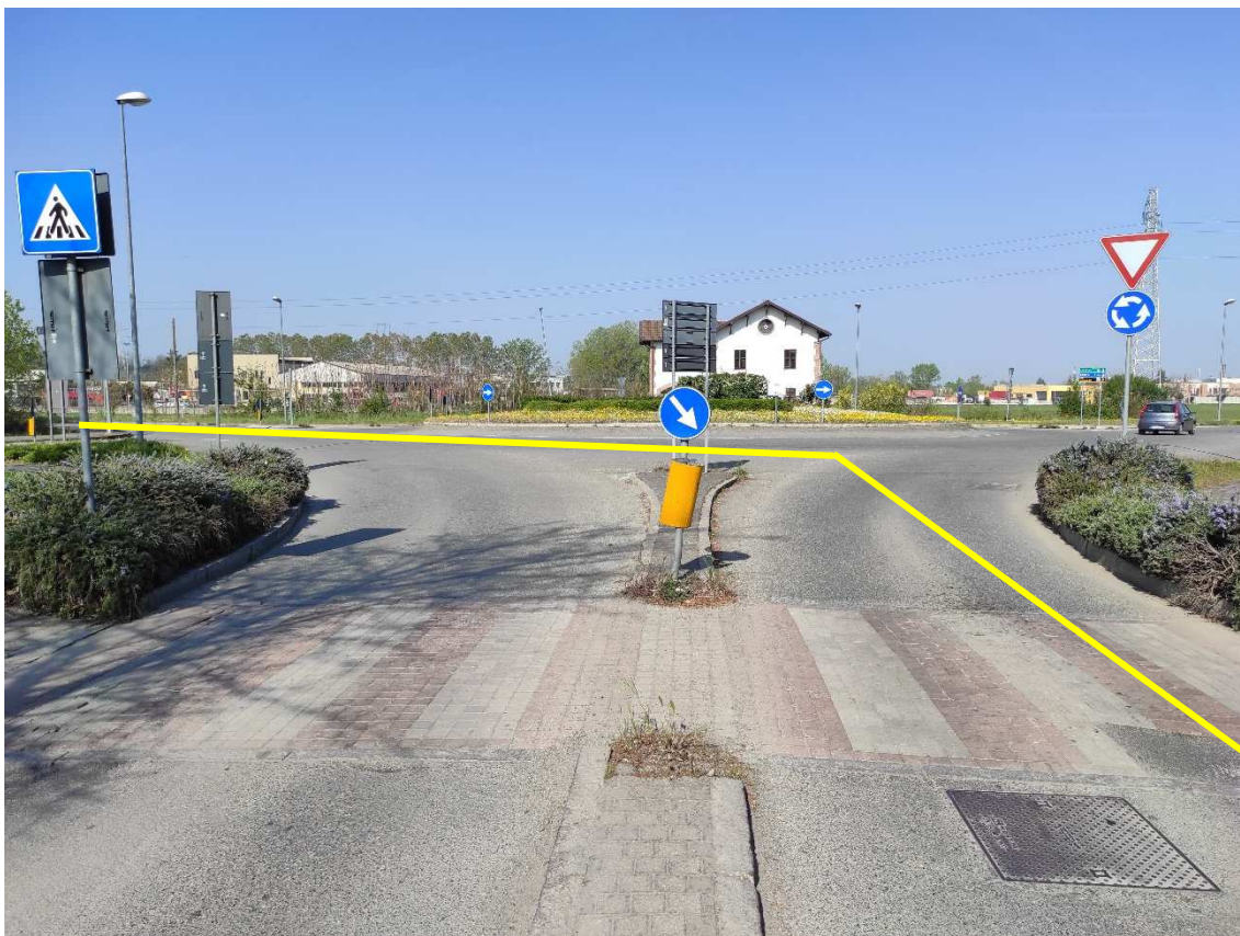
Figura 39. Via delle Filande - Posa linea elettrica su strada asfaltata
