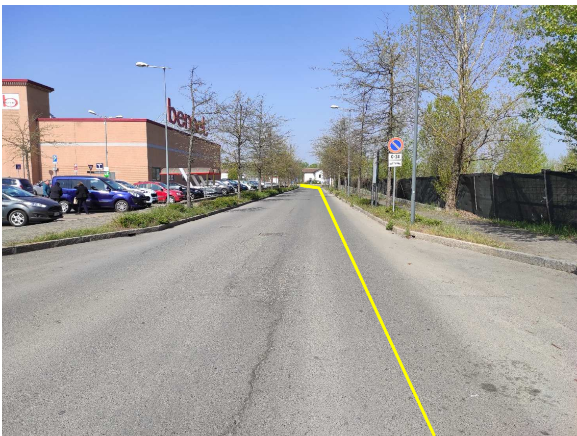
Figura 38. Via delle Filande - Posa linea elettrica su strada asfaltata
