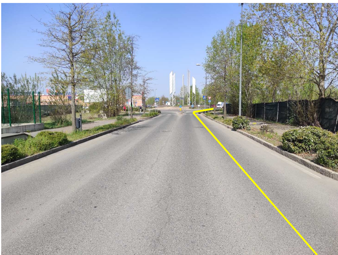
Figura 36. Via Nino Bixio - Posa linea elettrica su strada asfaltata
