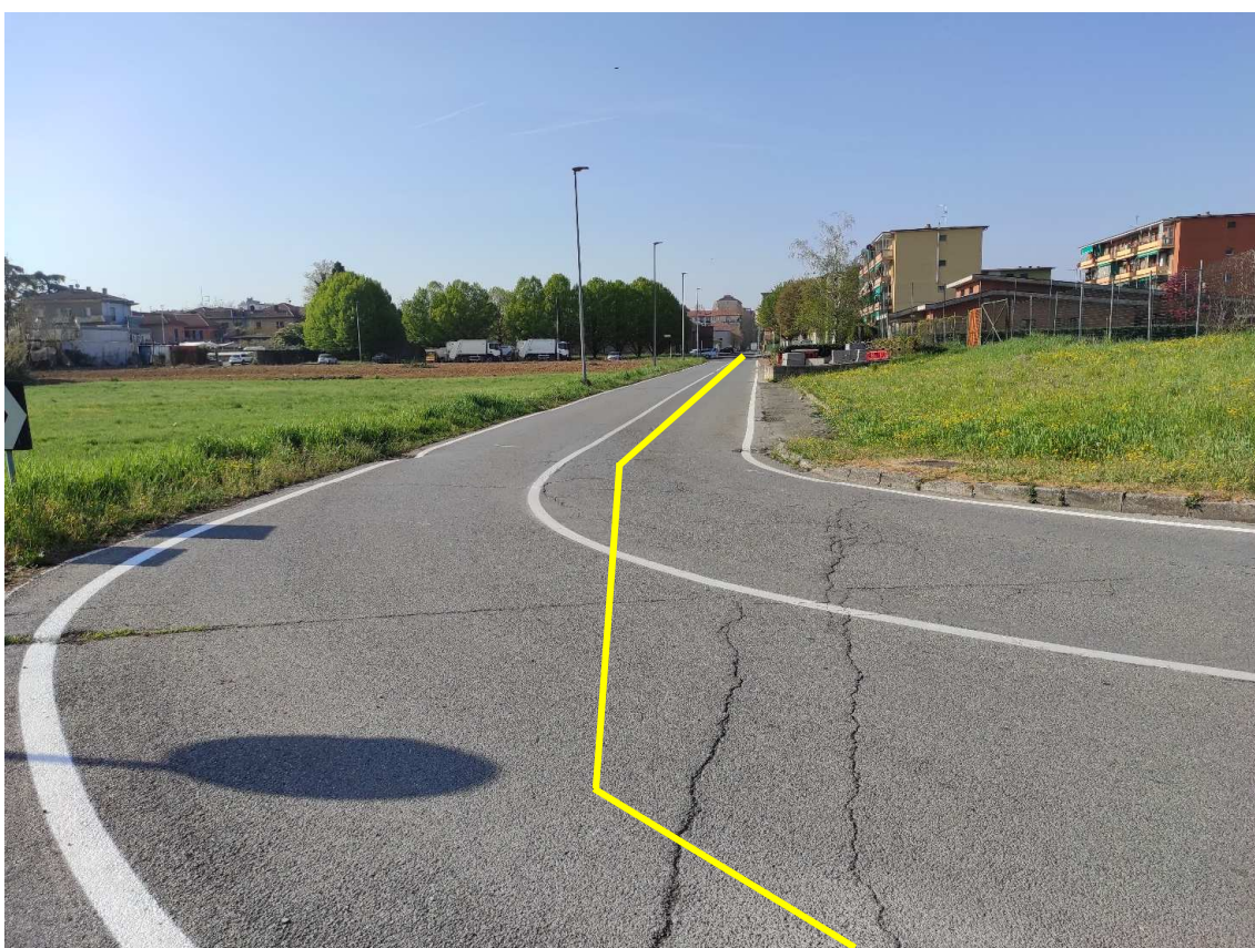
Figura 16. Via Pinan Cichero - Posa linea elettrica su strada asfaltata
