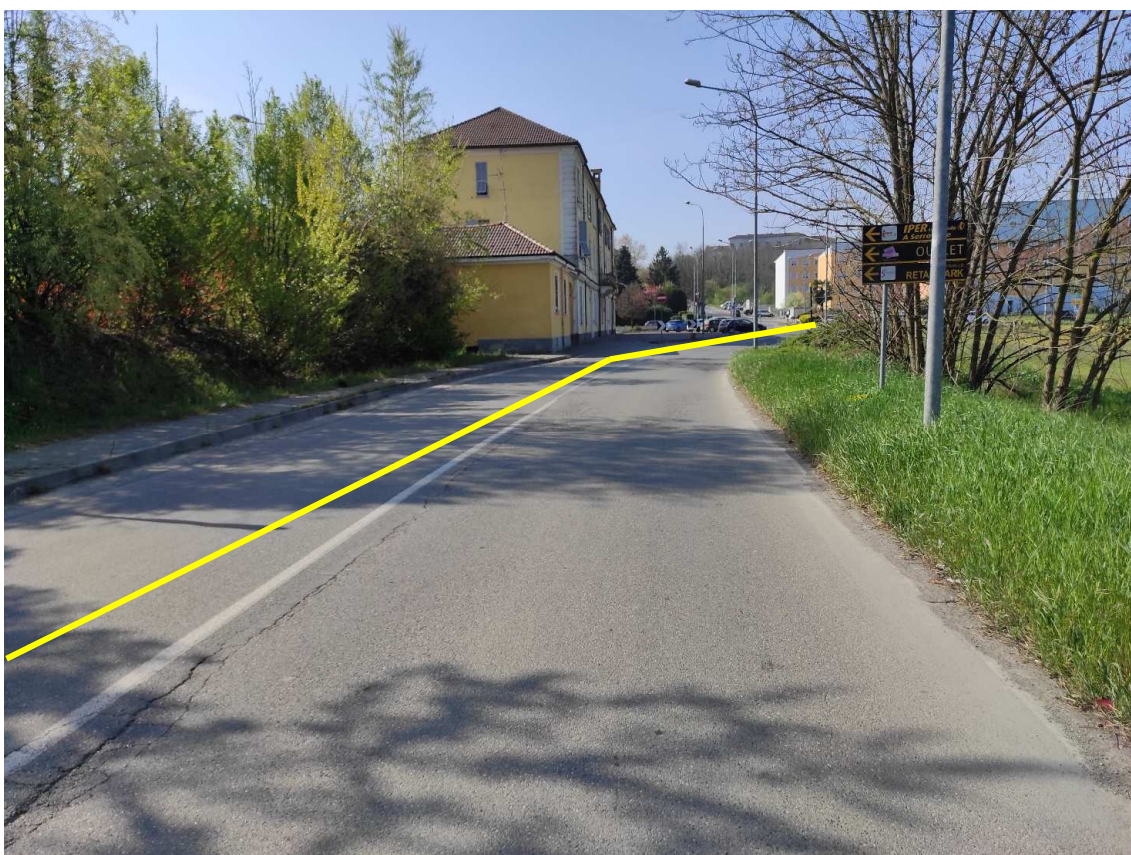
Figura 42. Via Trattato di Bruxelles - Posa linea elettrica su strada asfaltata
