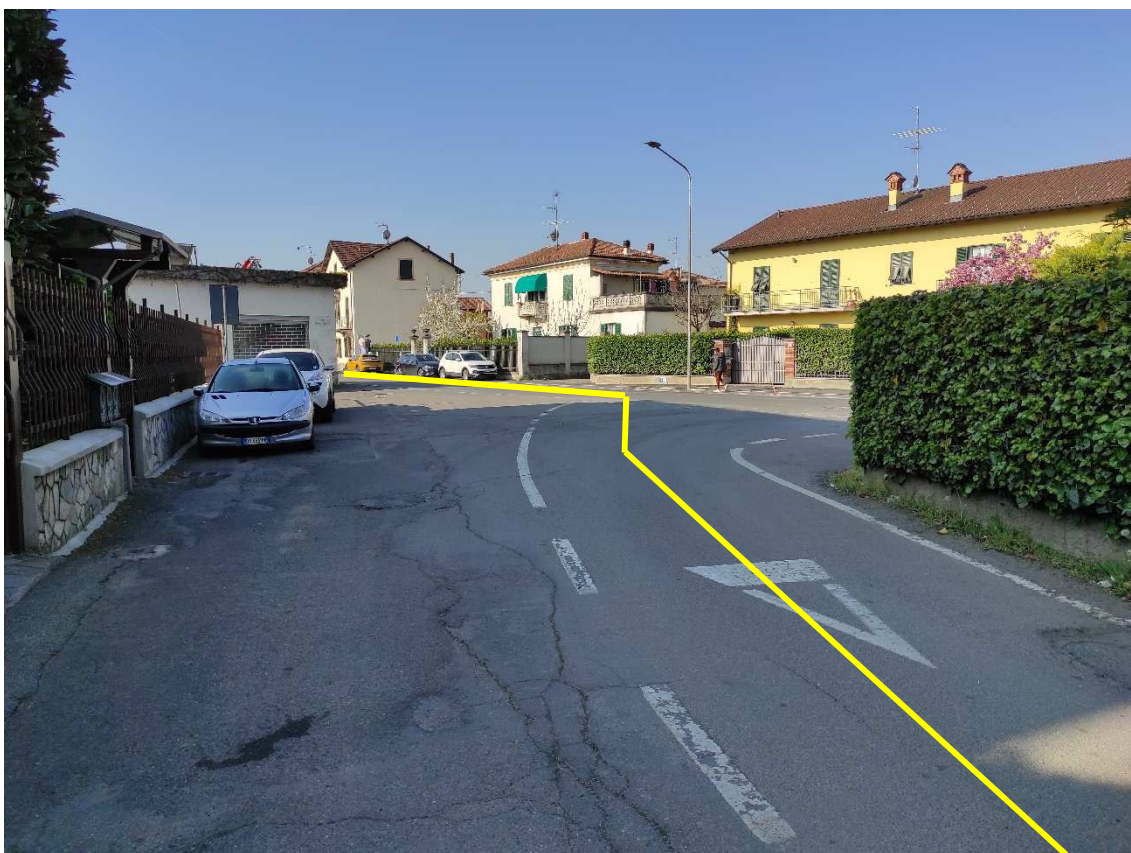
Figura 6. Incrocio Strada della Pavese-Via Mazzini - Posa linea elettrica su strada asfaltata
