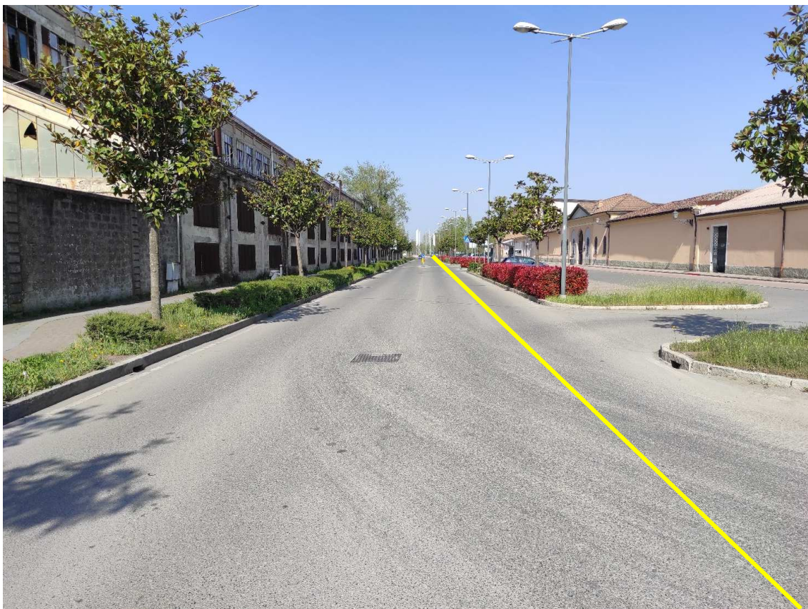
Figura 35. Via Nino Bixio - Posa linea elettrica su strada asfaltata
