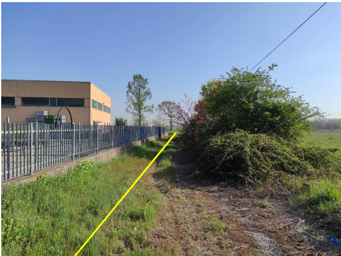
Figura 1. Posa linea elettrica su strada sterrata
