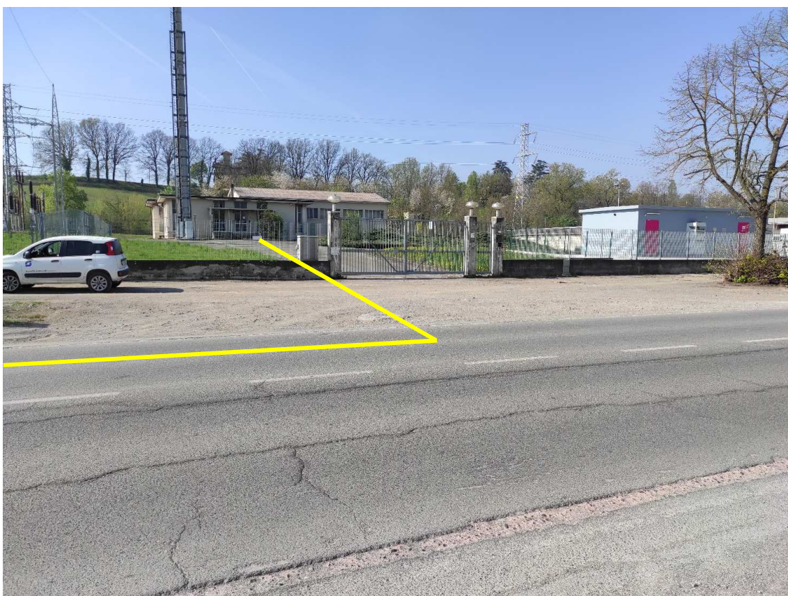
Figura 46. Strada del Turchino - Posa linea elettrica su strada asfaltata
