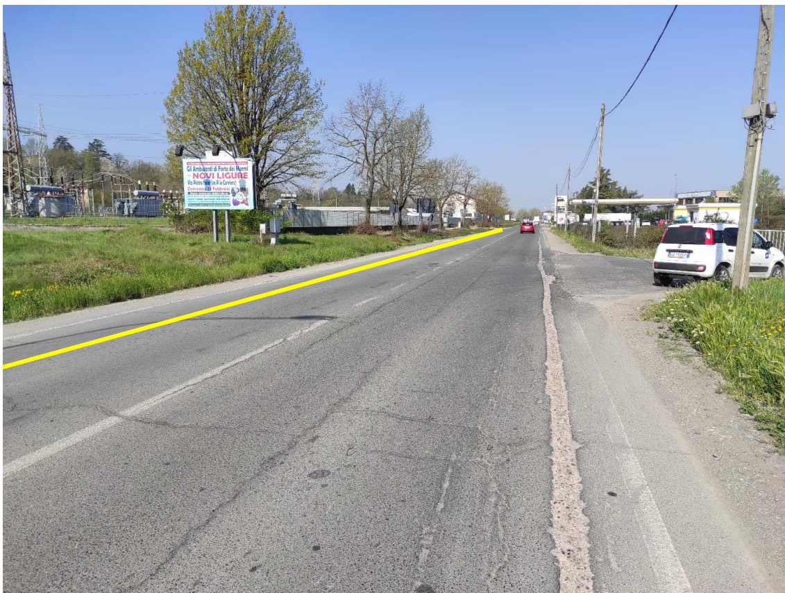
Figura 45. Strada del Turchino - Posa linea elettrica su strada asfaltata
