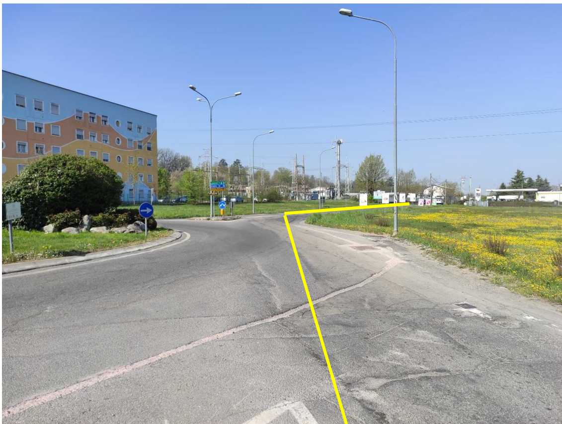
Figura 43. Incrocio Via Trattato di Bruxelles-Strada del Turchino - Posa linea elettrica su strada asfaltata
