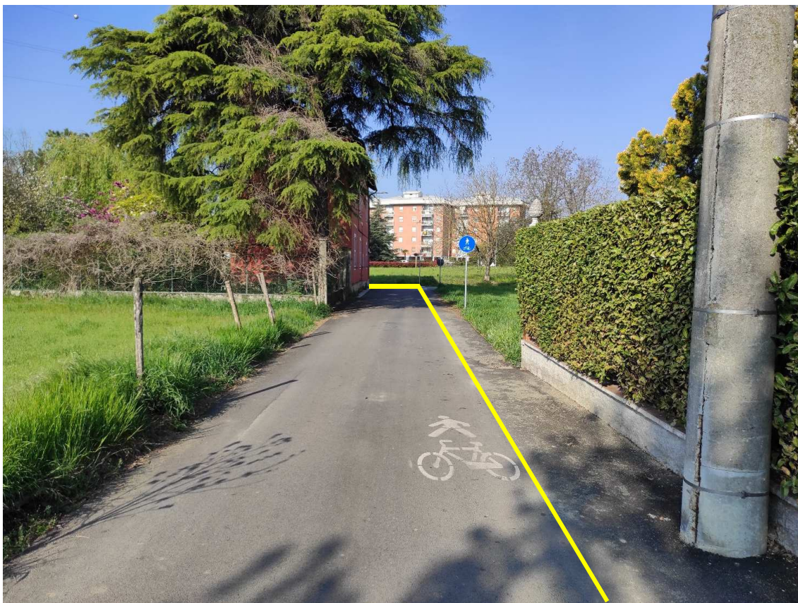
Figura 11. Via Monte Bianco - Posa linea elettrica su strada asfaltata
