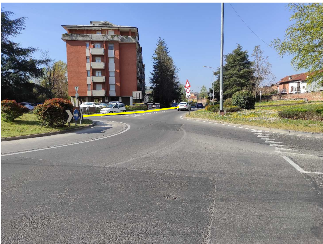
Figura 28. Incrocio Via Francesco Crispi-Via Carlo Acquistapace - Posa linea elettrica su strada asfaltata
