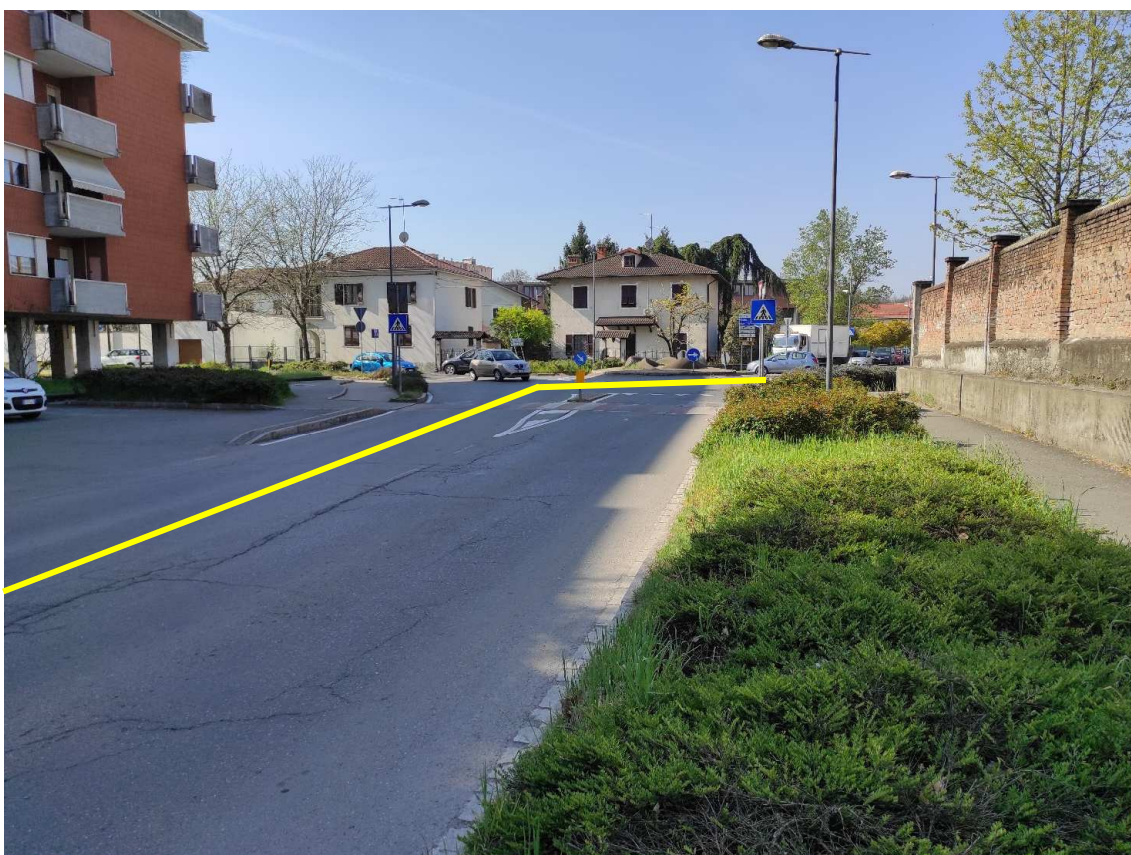
Figura 30. Via Carlo Acquistapace - Posa linea elettrica su strada asfaltata
