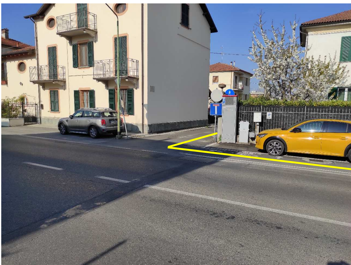
Figura 8. Incrocio Via Mazzini-Via Monte Bianco - Posa linea elettrica su strada asfaltata
