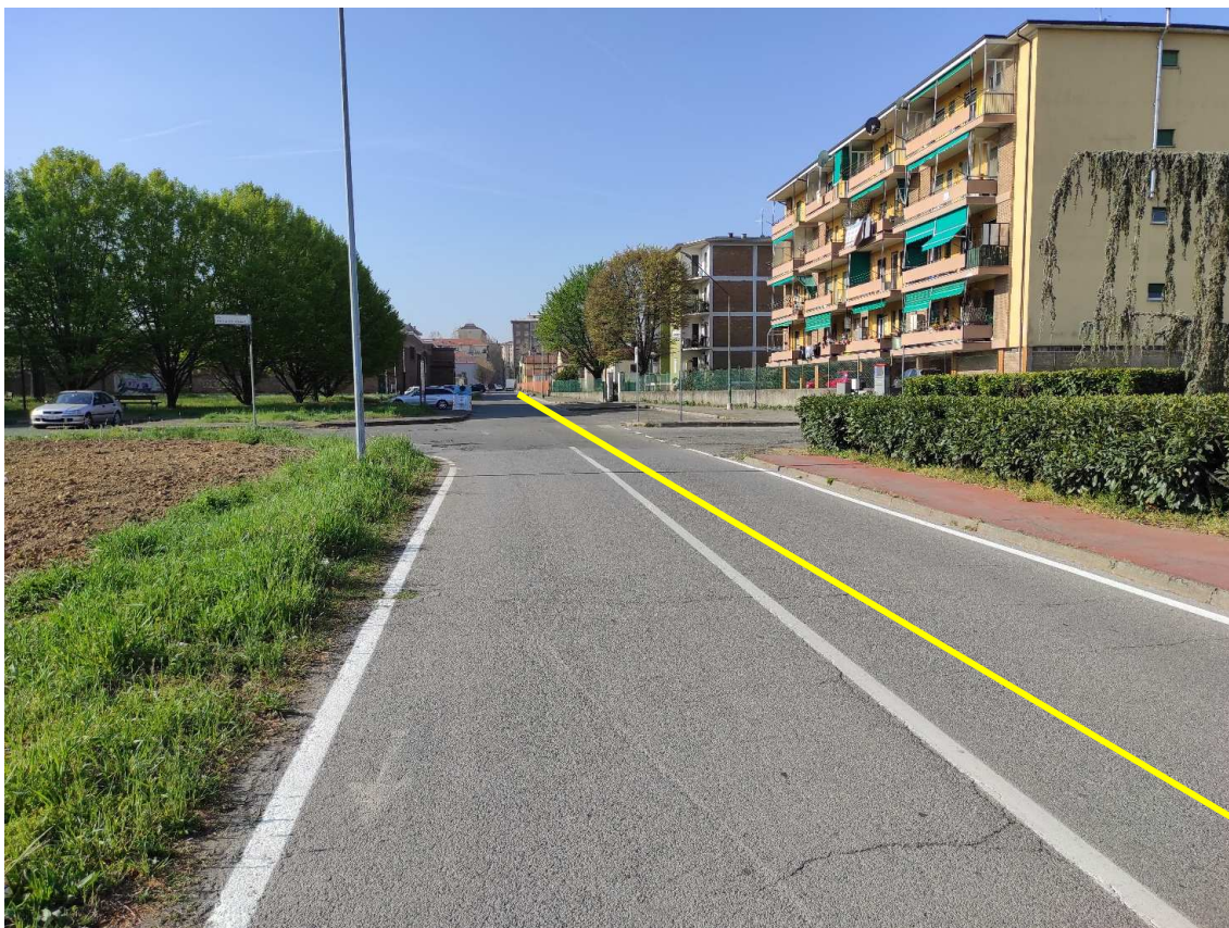
Figura 17. Via Pinan Cichero - Posa linea elettrica su strada asfaltata
