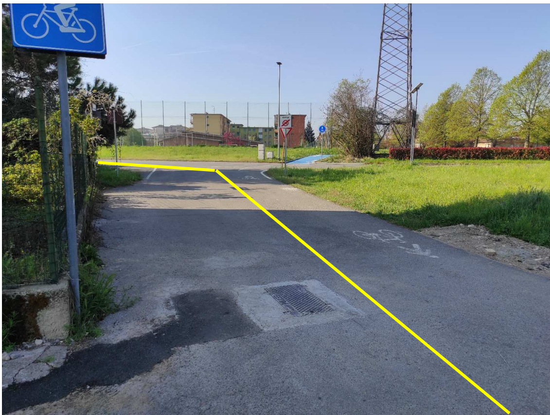
Figura 13. Strada Vecchia di Pozzolo - Posa linea elettrica su strada asfaltata
