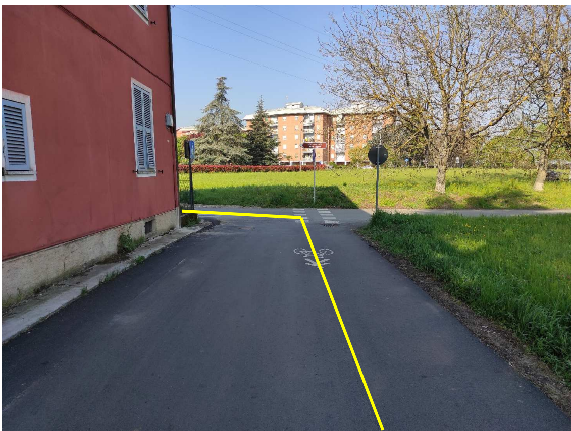
Figura 12. Incrocio Via Monte Bianco-Strada Vecchia di Pozzolo - Posa linea elettrica su strada asfaltata
