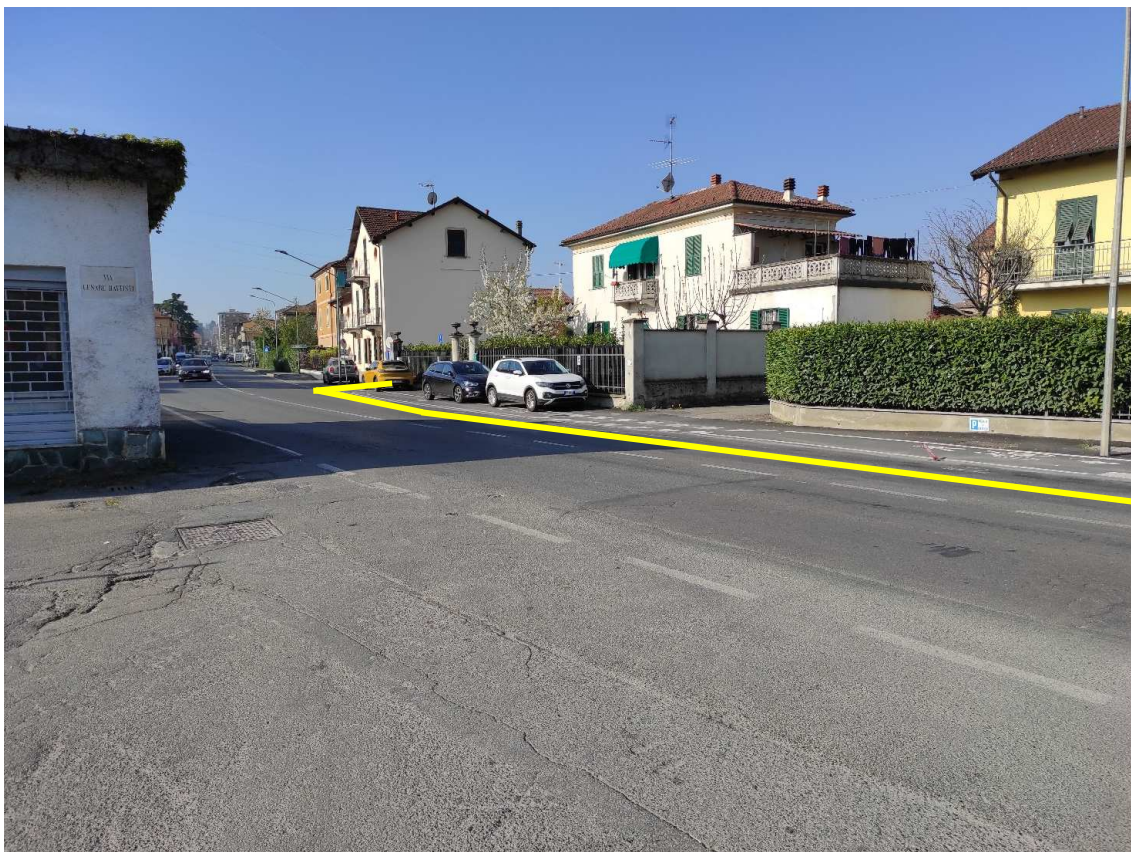
Figura 7. Via Mazzini - Posa linea elettrica su strada asfaltata
