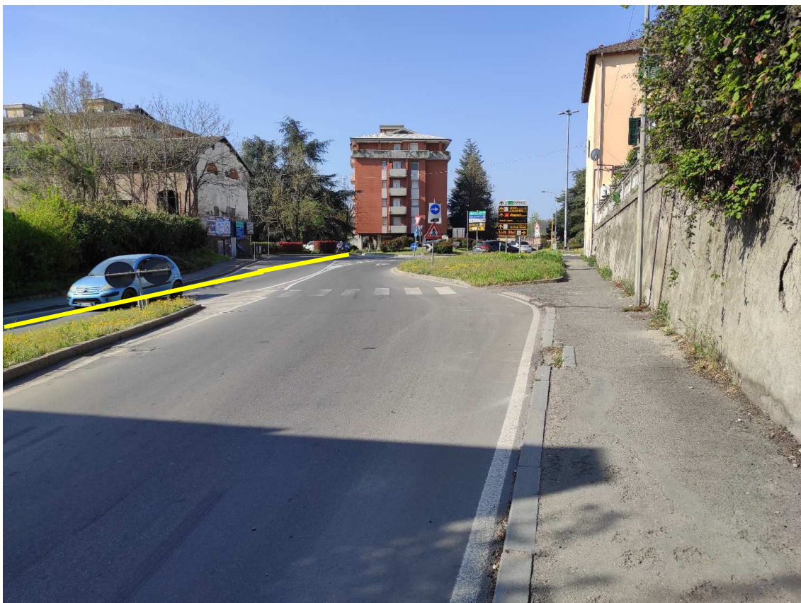
Figura 27. Via Francesco Crispi - Posa linea elettrica su strada asfaltata
