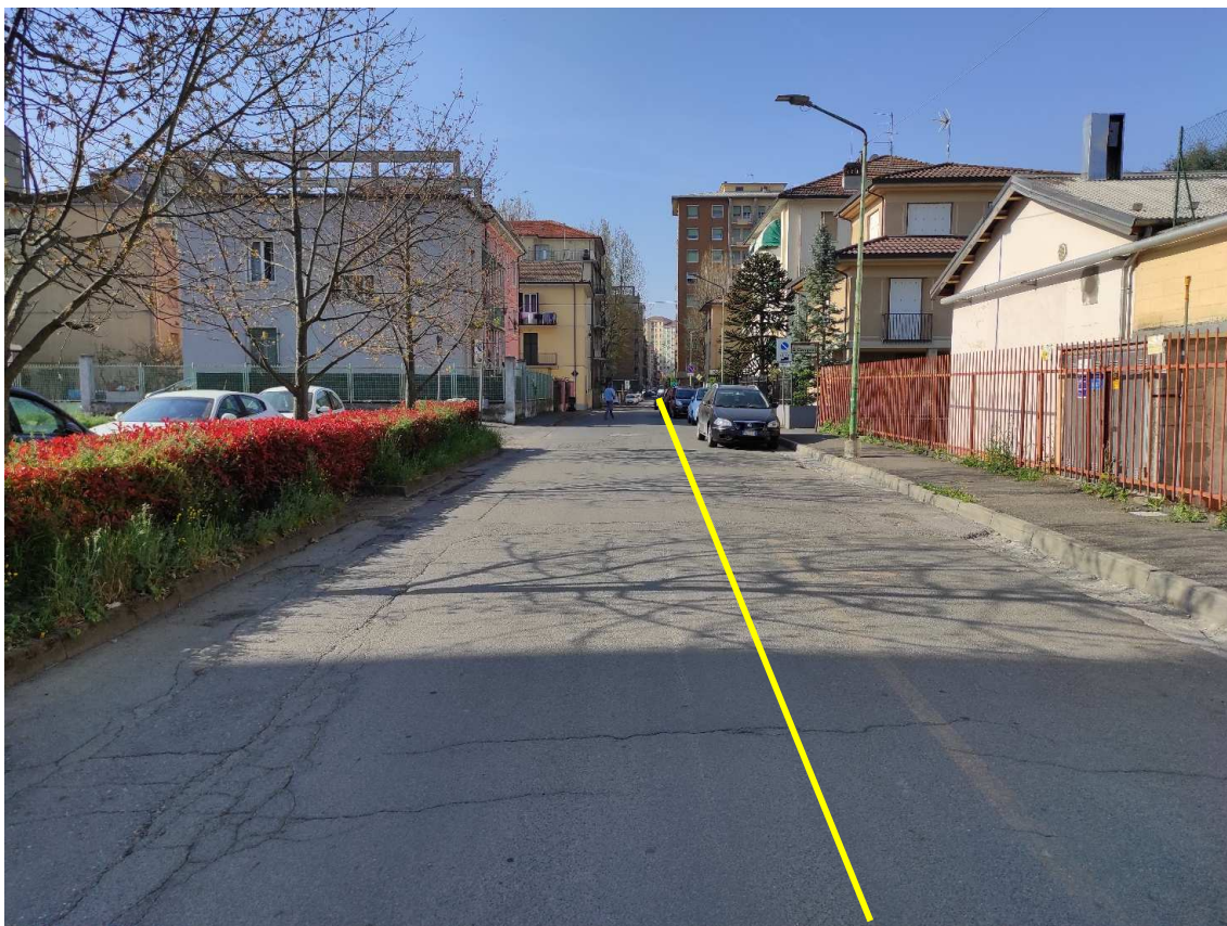
Figura 19. Via Pinan Cichero - Posa linea elettrica su strada asfaltata
