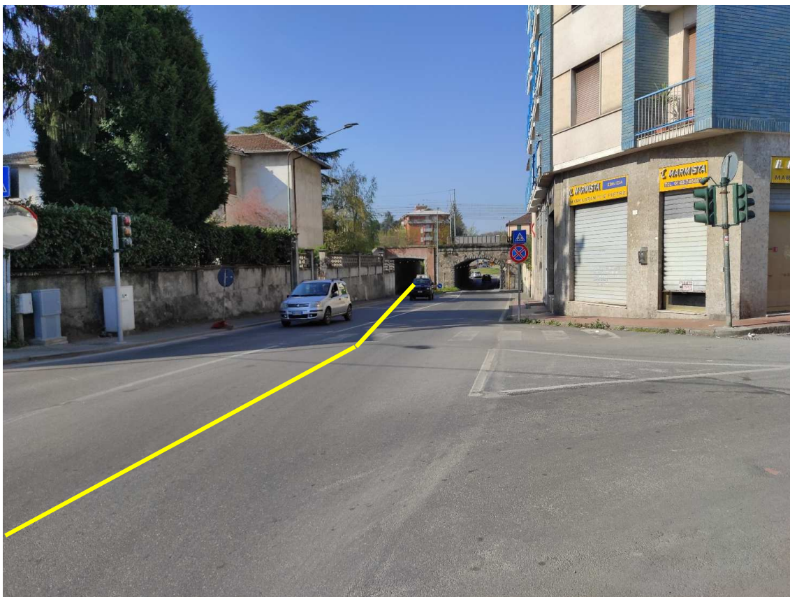
Figura 25. Via Francesco Crispi - Posa linea elettrica su strada asfaltata
