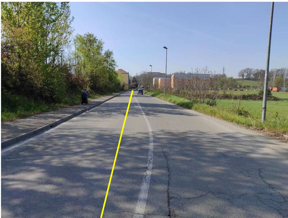
Figura 41. Via Trattato di Bruxelles - Posa linea elettrica su strada asfaltata
