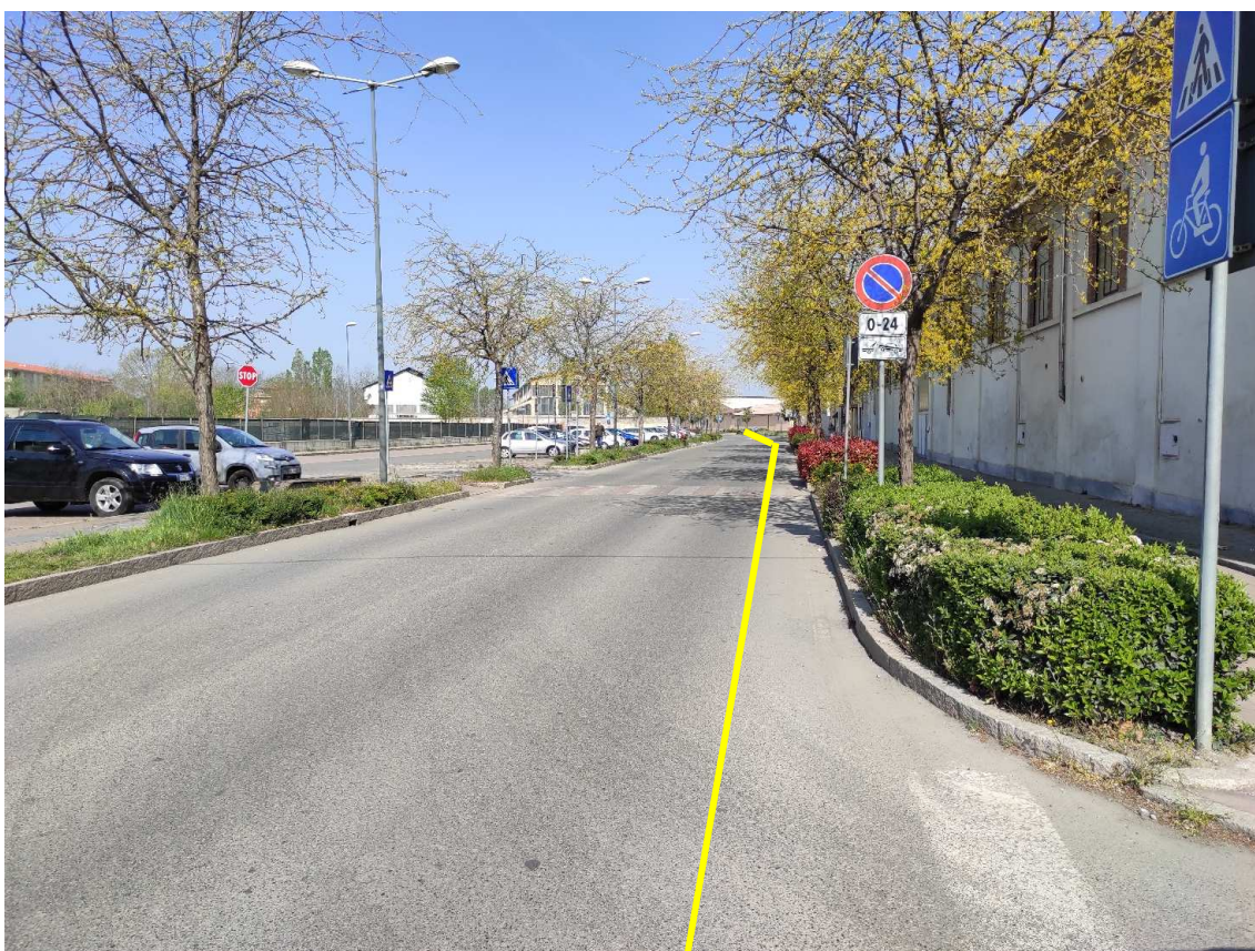
Figura 33. Via Nino Bixio - Posa linea elettrica su strada asfaltata
