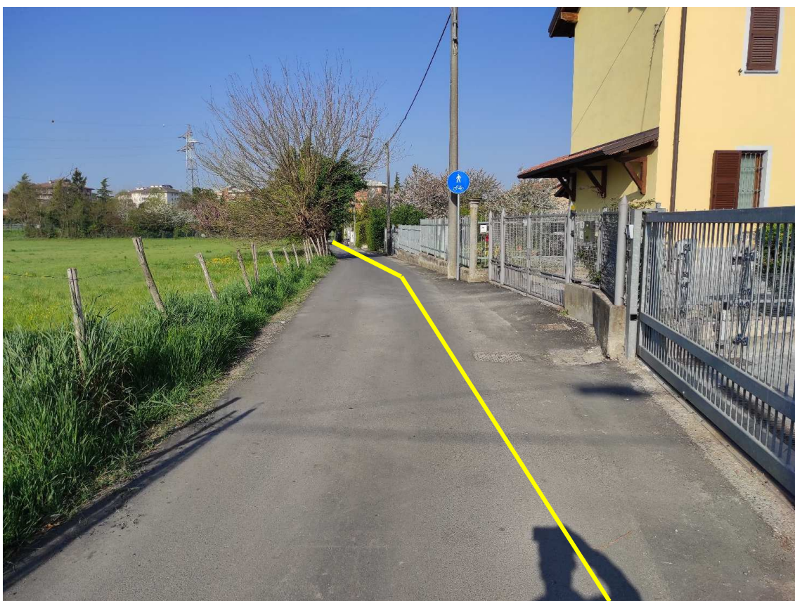
Figura 10. Via Monte Bianco - Posa linea elettrica su strada asfaltata
