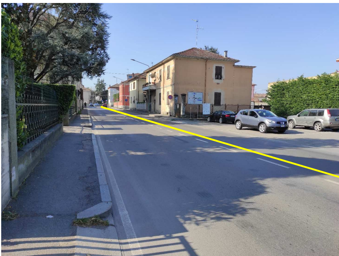
Figura 24. Via Francesco Crispi - Posa linea elettrica su strada asfaltata
