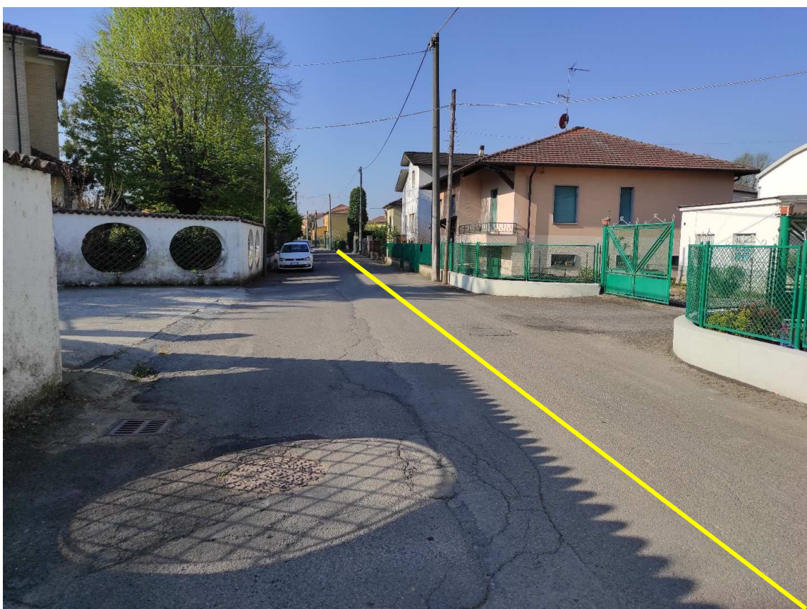
Figura 4. Strada della Pavese - Posa linea elettrica su strada asfaltata
