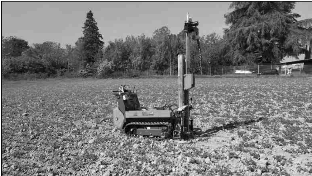
Foto n.1: Prova penetrometrica DPSH - P1
