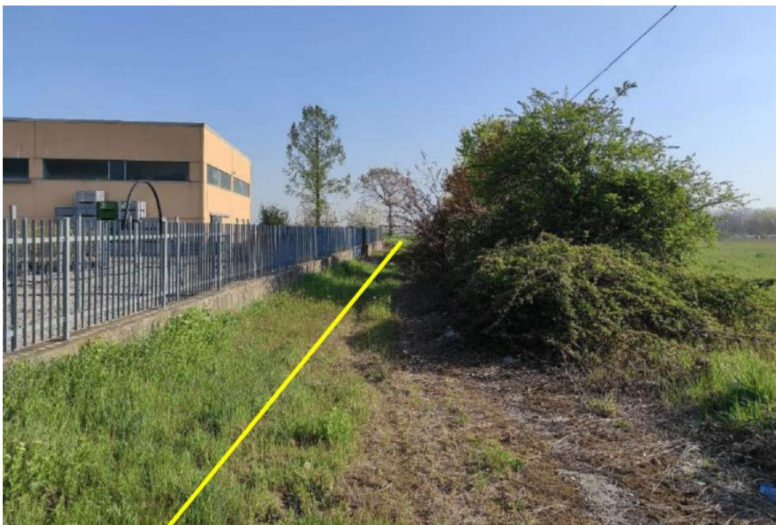
Figura 18 - Posa della linea elettrica (in giallo) in sezione stradale (pista sterrata)
