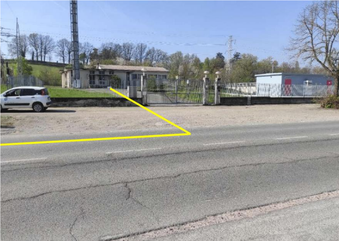
Figura 19 - Tratto finale della linea elettrica (in giallo) e cabina primaria MT/AT Novi Ligure
