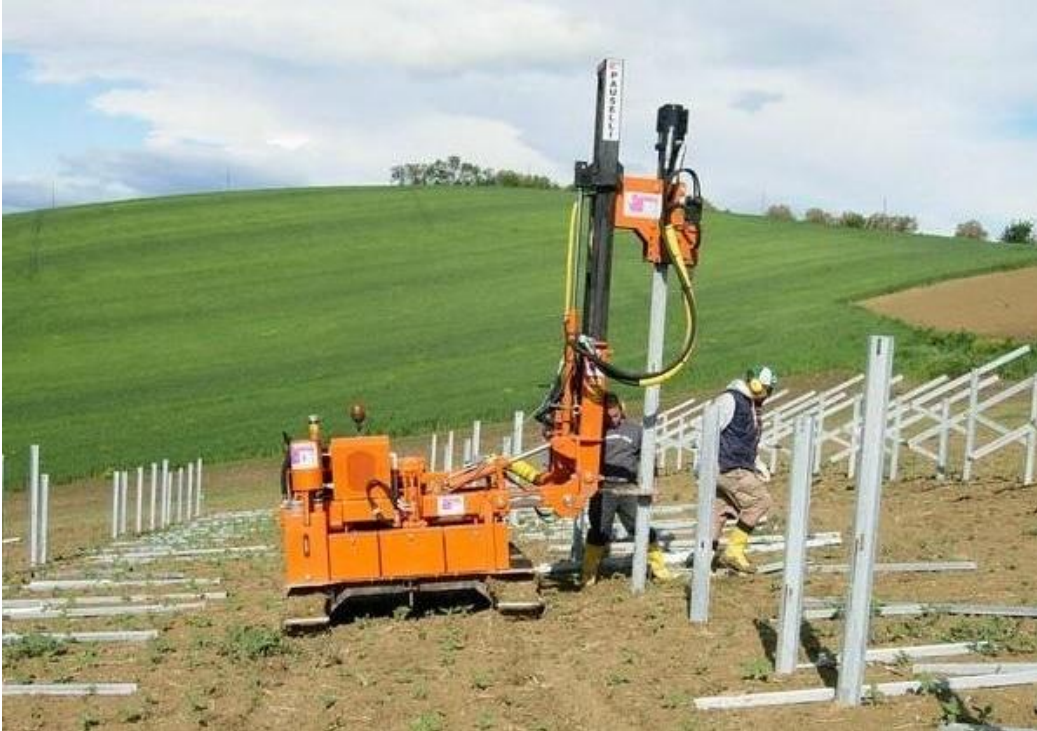
Figura 20 – Esempio di macchina battipalo per l'installazione di pannelli fotovoltaici
