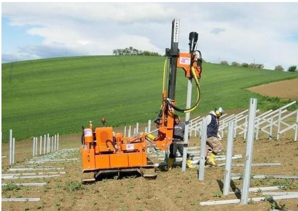
Figura 12 – Esempio di macchina battipalo per l'installazione di pannelli fotovoltaici
