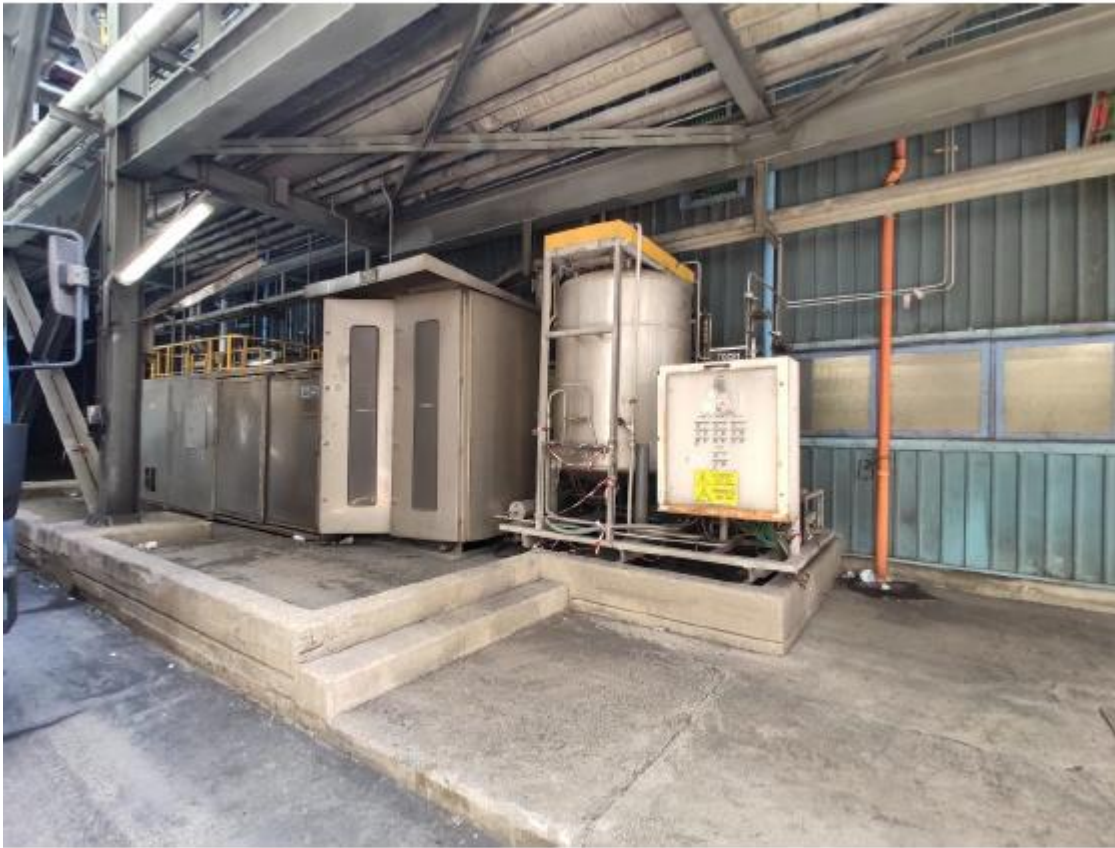
Figura 8-13 – Centro di Pericolo 3: area AM17 Edificio ausiliario gruppi 2 – serbatoio di ammoniaca su area pavimentata, cordolata e coperta
