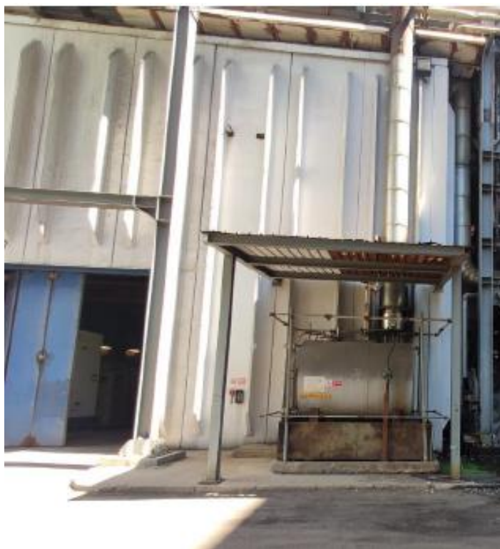
Figura 8-6 – Centro di Pericolo 3: area AM12 Zona edificio ausiliario gruppi 3/4 – serbatoio di gasolio con bacino contenimento e tettoia
