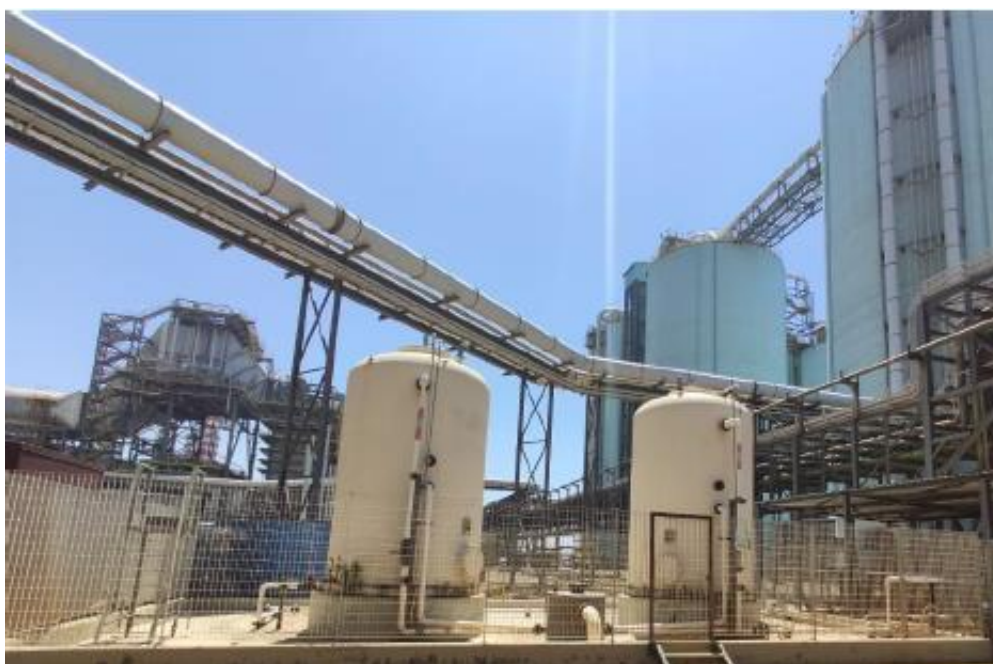
Figura 8-8 – Centro di Pericolo 3: area AM13 Area vasche griglia lato Tarquinia – Serbatoio ipoclorito di sodio su area cementata e recintata con muretto di contenimento
