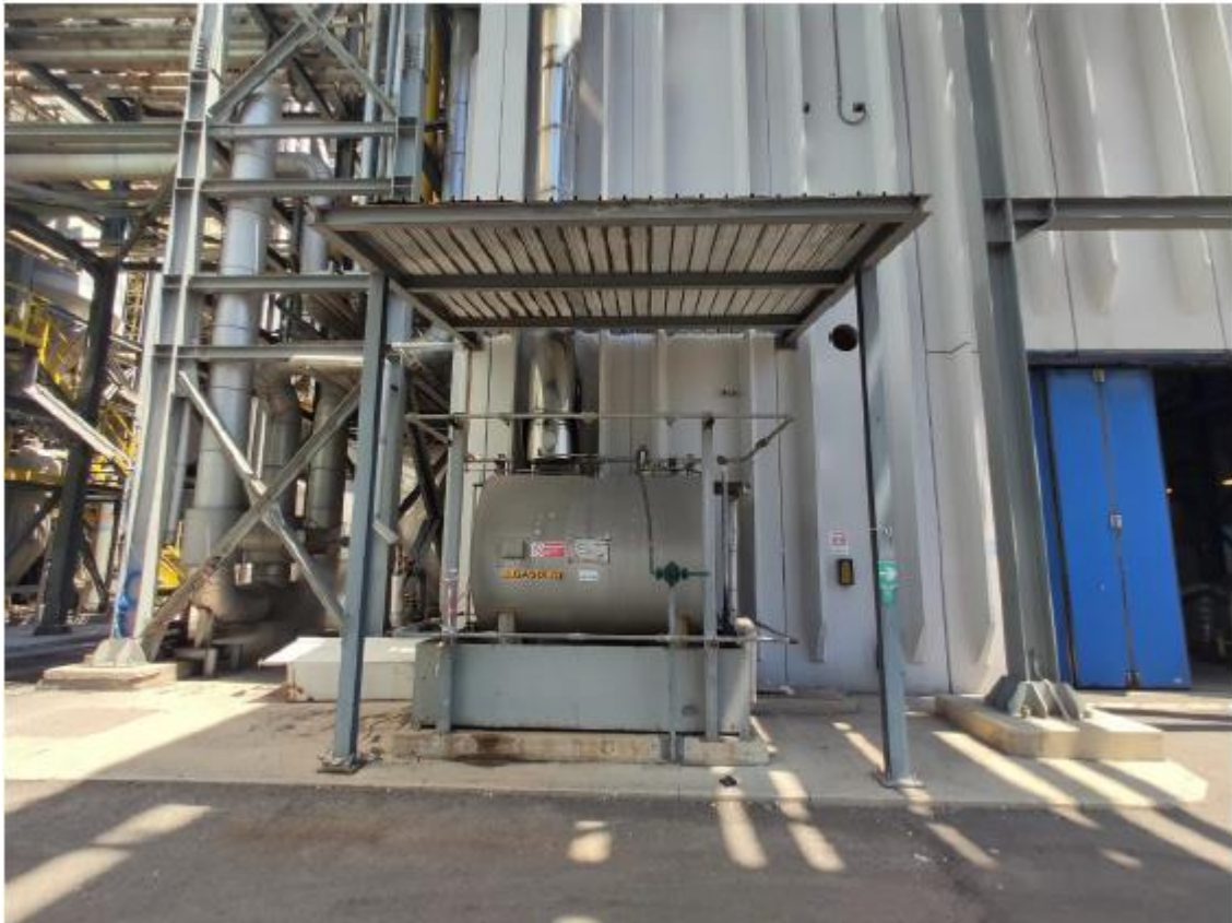
Figura 8-12 – Centro di Pericolo 3: area AM17 Edificio ausiliario gruppi 2 – serbatoio di gasolio con bacino di contenimento e tettoia
