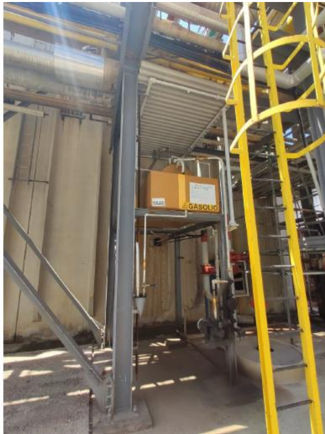
Figura 8-4 – Centro di Pericolo 3: area AM5 Edificio letti misti ex evaporatore – serbatoio gasolio con bacino contenimento e copertura
