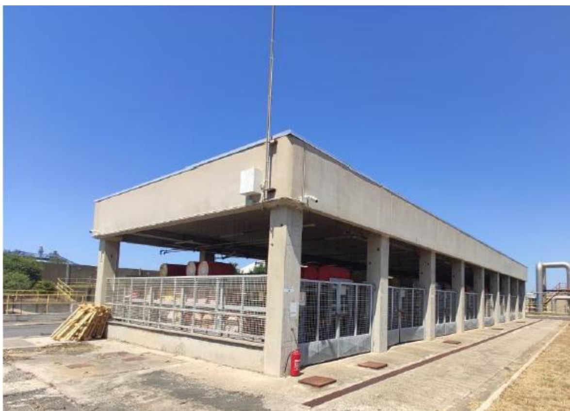
Figura 8-1 – Centro di Pericolo 1: area AM6 a Deposito olii – area pavimentata dotata di copertura fissa con muretto di contenimento
