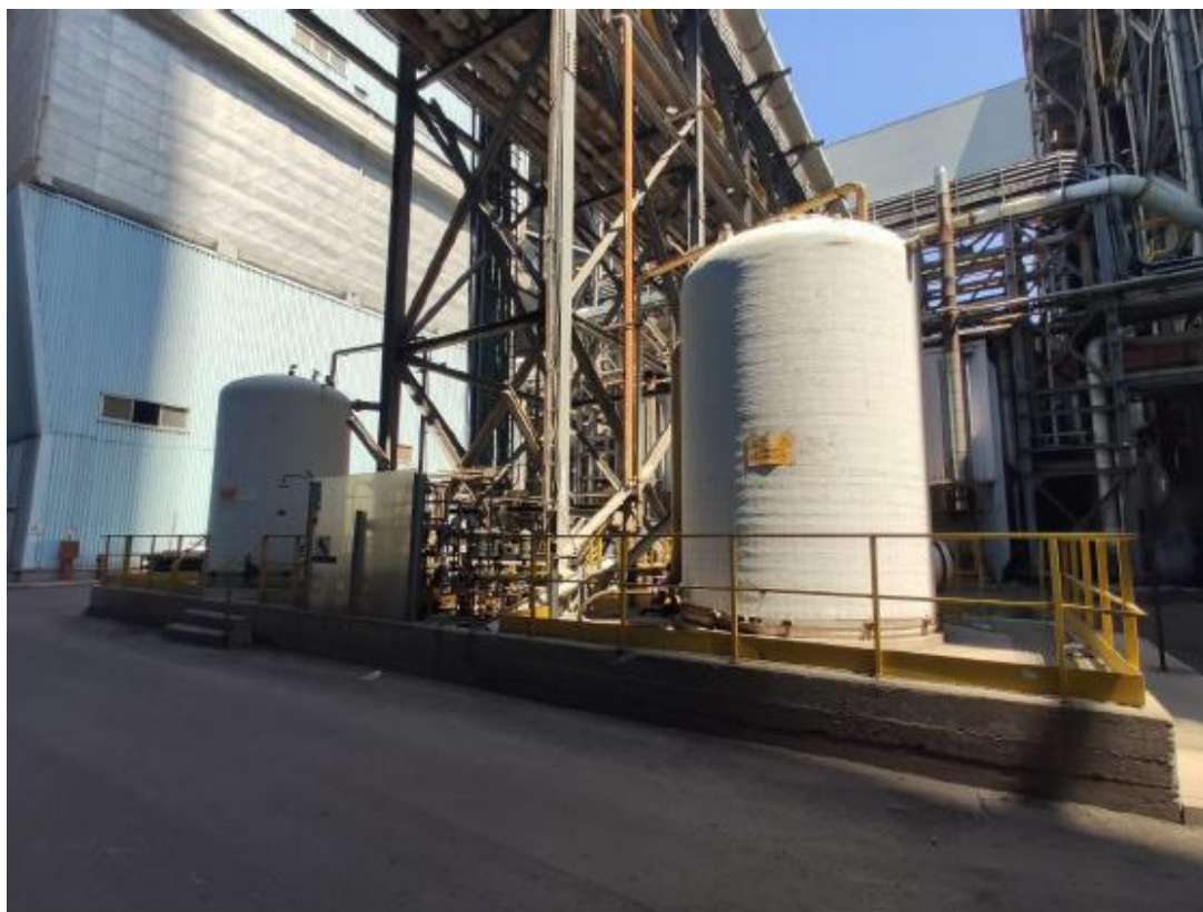
Figura 8-9 – Centro di Pericolo 3: area AM14 Area esterna edificio ausiliario gruppi 3/4 lato mare – serbatoi cloruro ferroso su area cementata con muretto di contenimento
