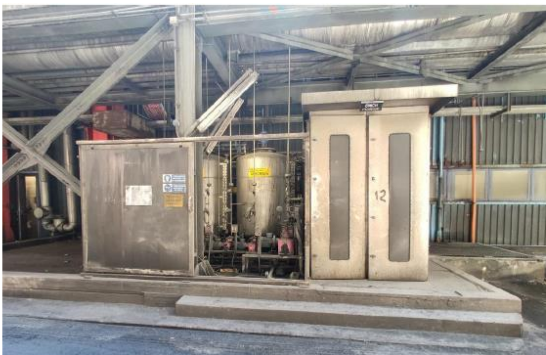
Figura 8-7 – Centro di Pericolo 3: area AM12 Zona edificio ausiliario gruppi 3/4 – serbatoi di ammoniaca con bacino contenimento su area cordolata e coperta
