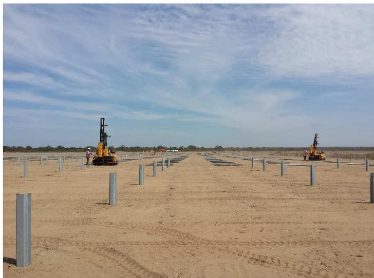
Il supporto post guidato non richiede una base concreta. Il palo è un profilo in acciaio omega per massimizzare la superficie di contatto con il terreno, la profondità dipende dal tipo di terreno. Una tipica flangia di 5 cm viene utilizzata per pilotare il montante con un autista che dovrebbe avere una guida per mantenere la direzione di inserimento entro le tolleranze minime.
