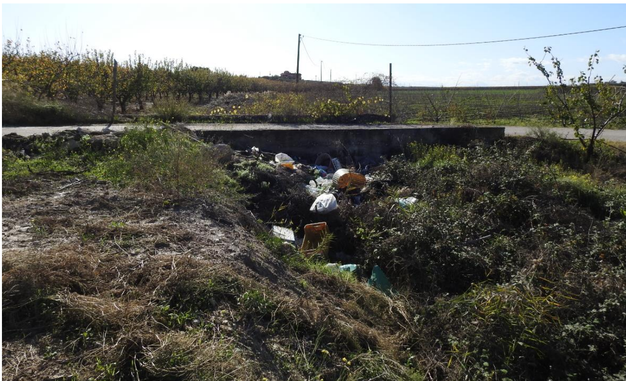
Figura 17 – Stato di fatto nel punto di attraversamento del Fosso Marana di Castello
