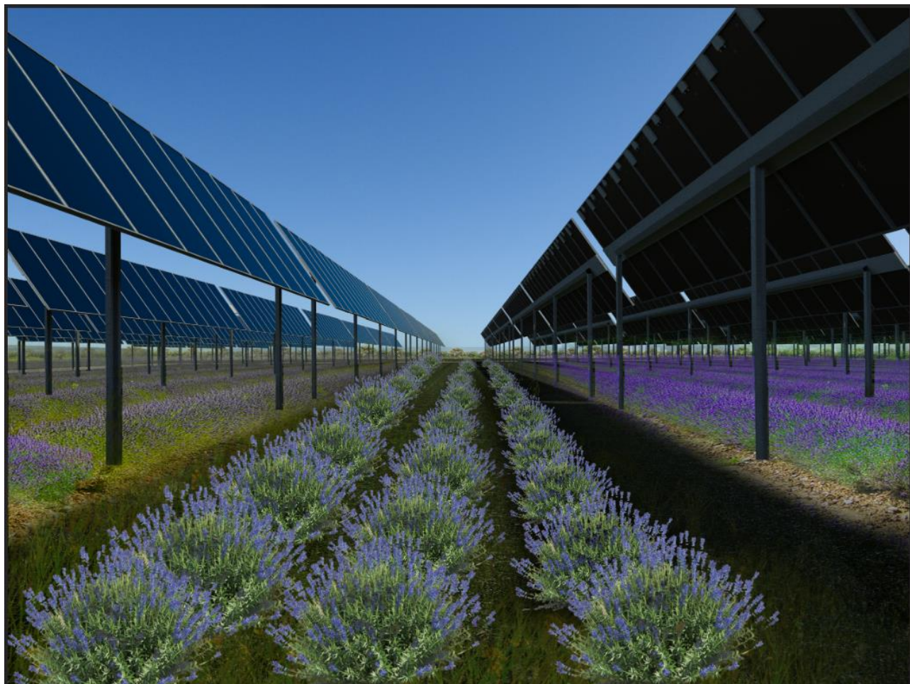
Figura 1 – Fotosimulazione della soluzione adottata con tracker alto monoassiale e distanza tra le file di moduli pari a 5,5 m. Per dettagli sul piano di coltivazione vedi VZYY142_4.2.6_14_ProgettoAgronomicoPaesaggistico
