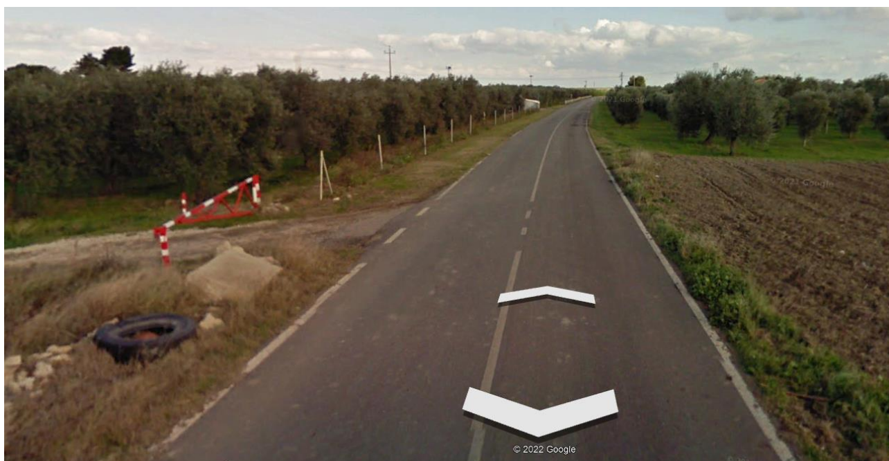
Figura 32 - Stato di fatto del Regio Tratturello n. 40 “Salpitello di Tonti – Trinitapoli” lungo il tracciato della SP68 in prossimità del campo FV di Acquarulo
