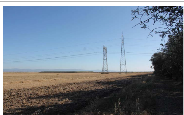
Rilievo fotografico in campo del 10/06/2020
