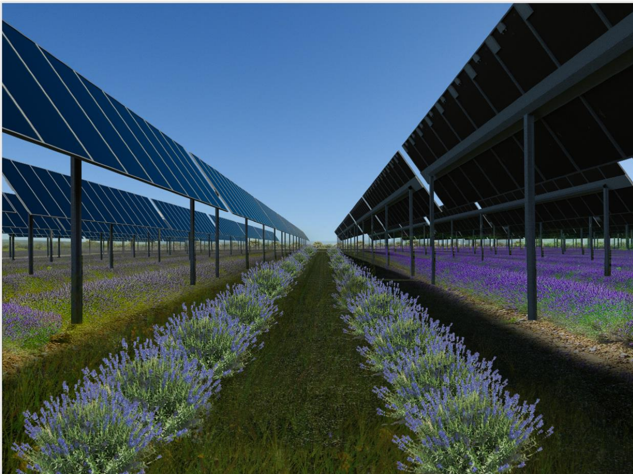
Figura 16 – Fotosimulazione della soluzione adottata con tracker alto monoassiale e distanza tra le file di moduli pari a 5,5 m. In primo piano la coltivazione di lavandino
