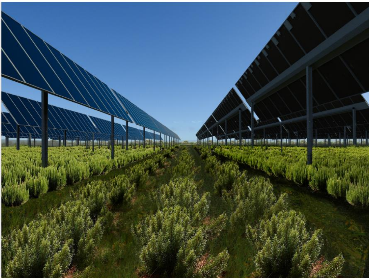
Figura 17 – Fotosimulazione della soluzione adottata con tracker alto monoassiale e distanza tra le file di moduli pari a 5,5 m. In primo piano la coltivazione di rosmarino
