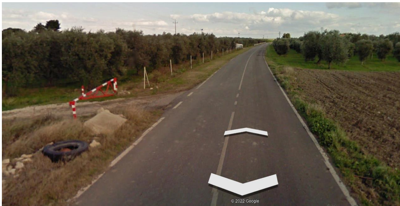
Figura 67 - Stato di fatto del Regio Tratturello n. 40 “Salpitello di Tonti – Trinitapoli” lungo il tracciato della SP68 in prossimità del campo FV di Acquarulo
