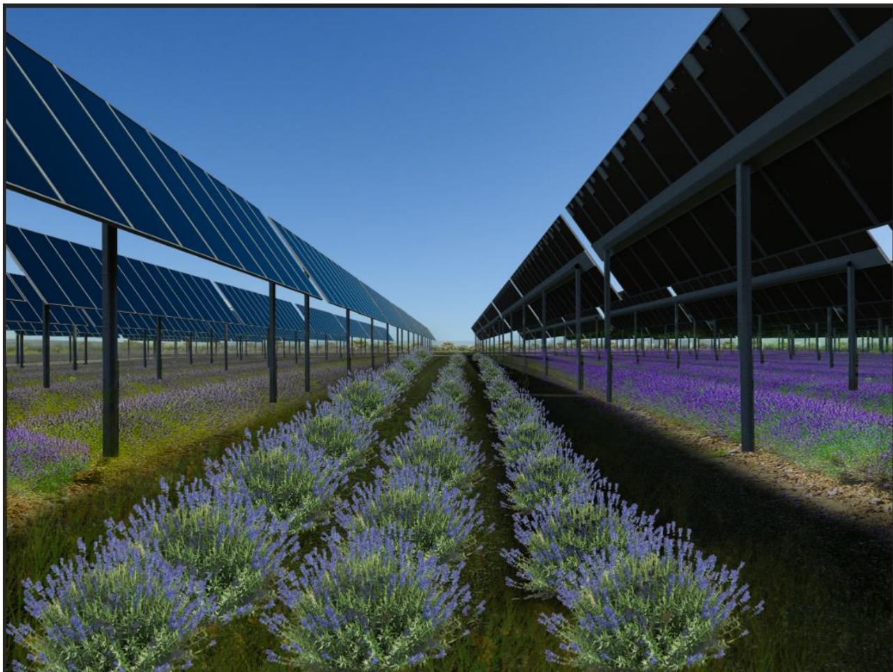
Figura 15 – Fotosimulazione della soluzione adottata con tracker alto monoassiale e distanza tra le file di moduli pari a 5,5 m. In primo piano la coltivazione di lavanda
