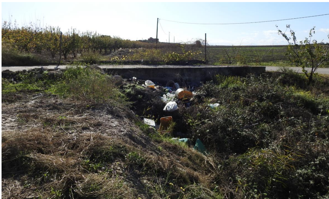
Figura 26 – Stato di fatto nel punto di attraversamento del Fosso Marana di Castello
