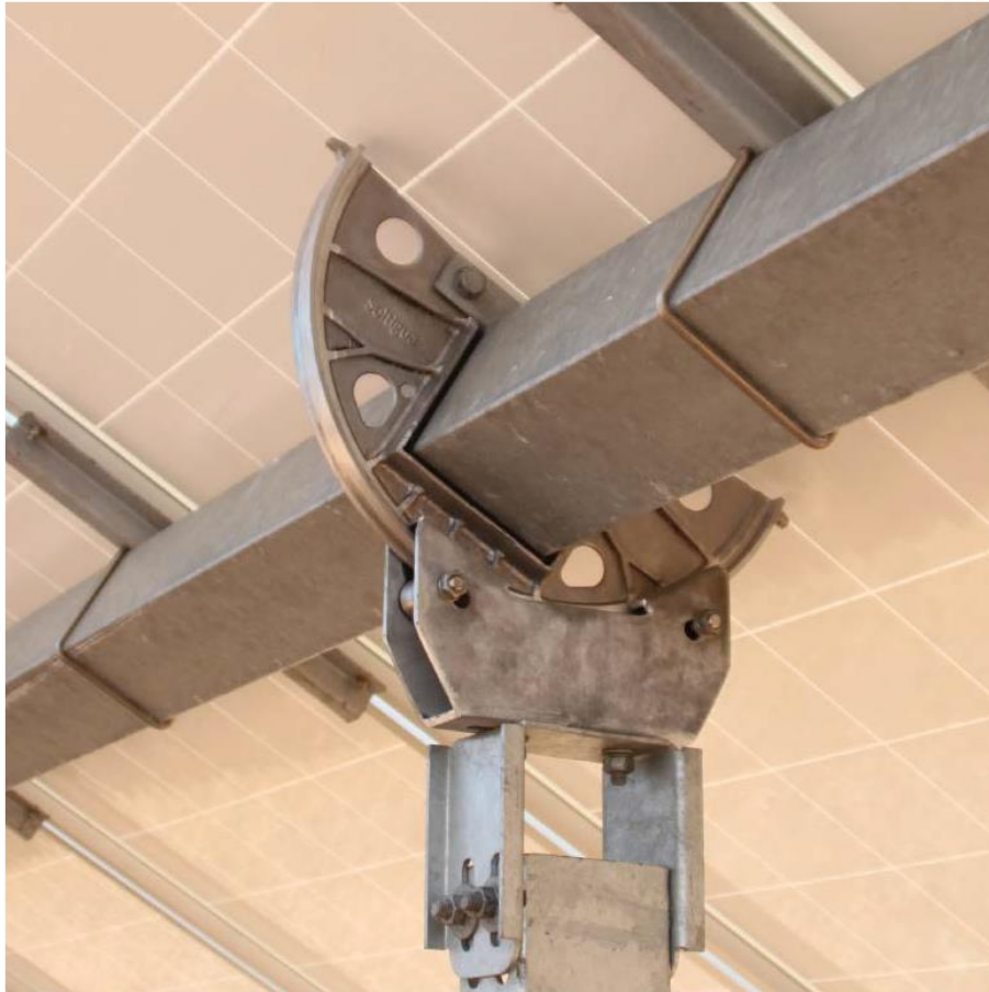
Schema nodo trave-pilastrino
