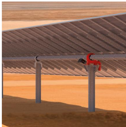
Figura 3 - Inseguitori solari monoassiali
