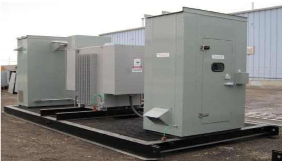
*Fig.3 base portante in carpenteria metallica zincata a caldo e impermeabilizzata*
