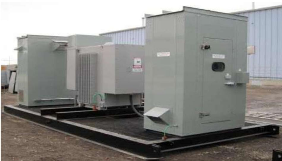
*Figura 10: Base portante in carpenteria metallica zincata a caldo impermeabilizzata*
