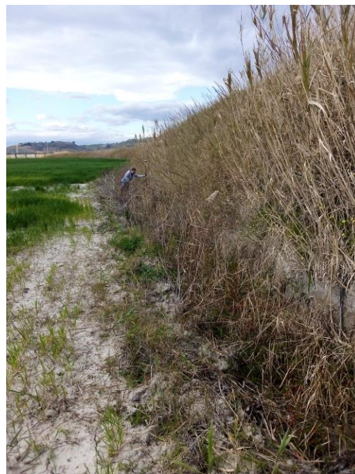
Foto 2: Argine in destra idraulica.
