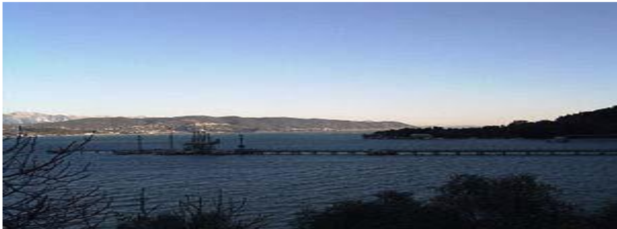
Foto 2 - Foto n. 2 Pontile di attracco
