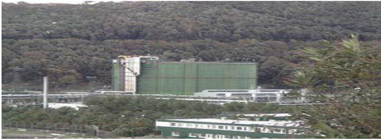
Foto 4 - Serbatoi di stoccaggio verso il monte
