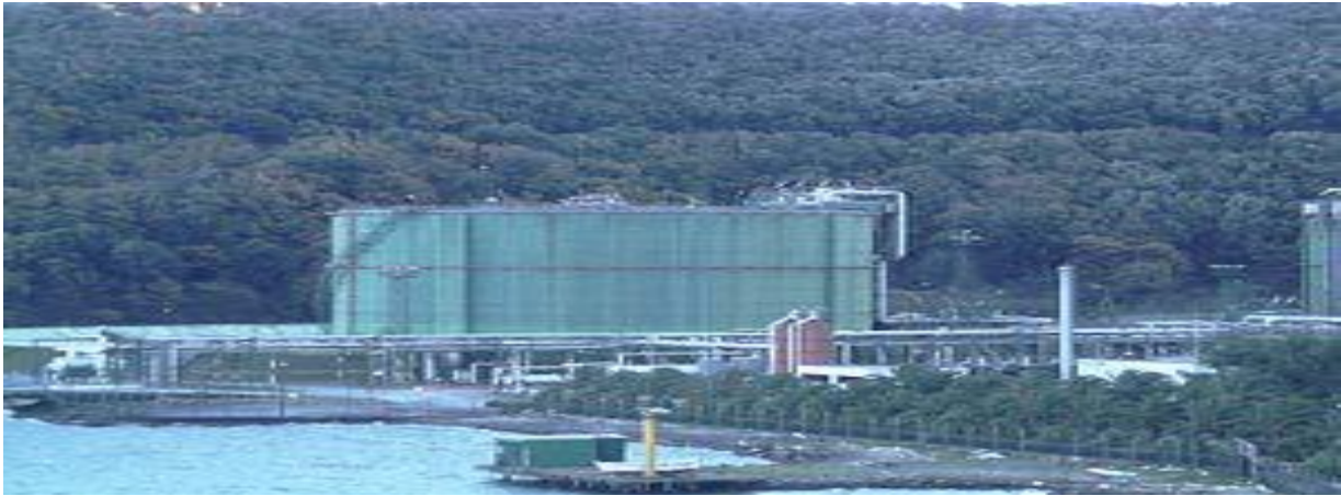
Foto 3 - Serbatoi di stoccaggio verso il mare
