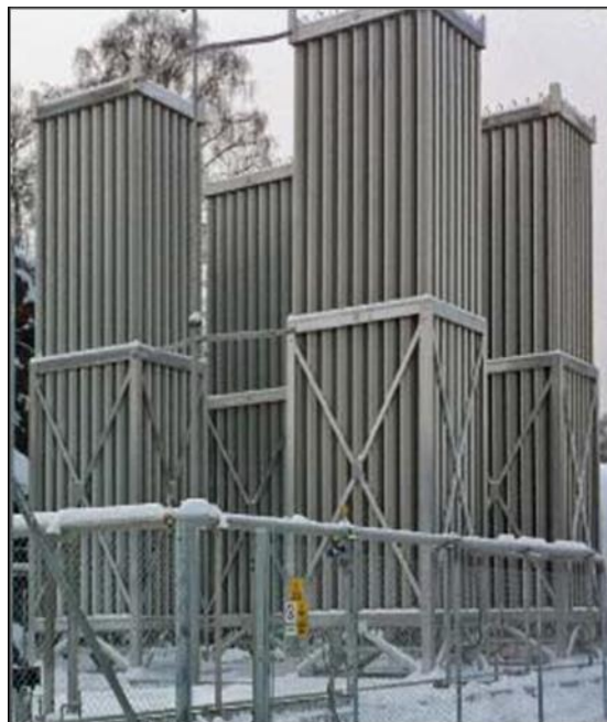
Figura 30 - Vaporizzatori AAV
