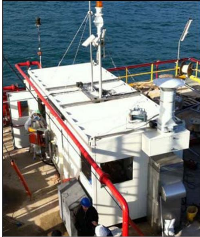
Figura 16 - Esempio Control room
