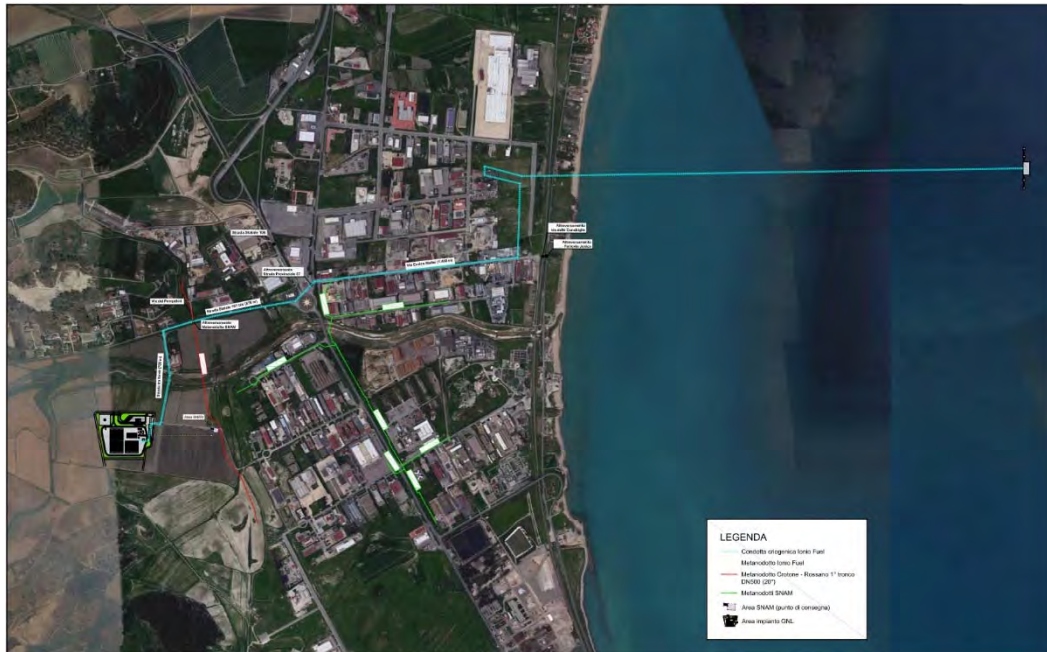
Figura 38 - Gasdotti SNAM presenti nell'area industriale in adiacenza al sito dell'impianto e viabilità consortile
