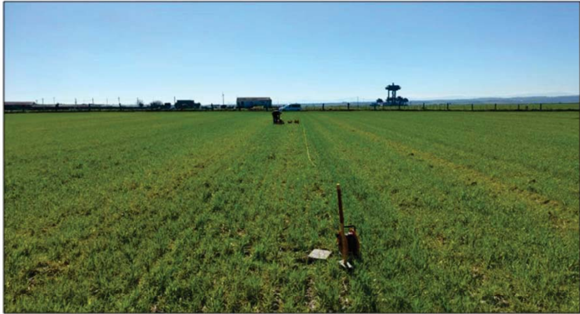
Foto 12 - Esecuzione indagine MASW - lato Nord
