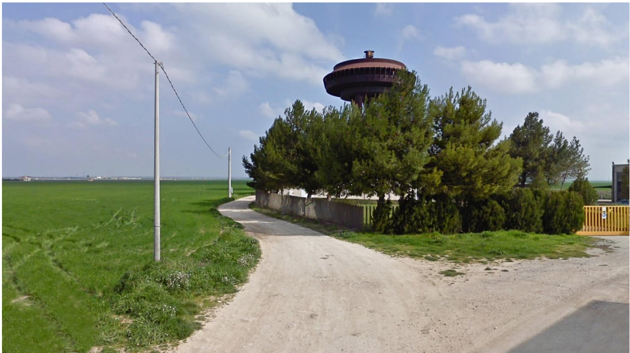
Figura 5-9 - Visuale PV01 ante operam presso Consorzio di Bonifica Distretto Fortore in direzione est
