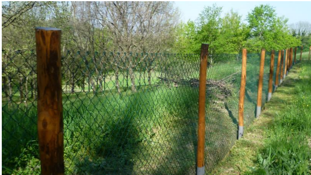
Figura 2-5 - Esempio di recinzione posta in opera
