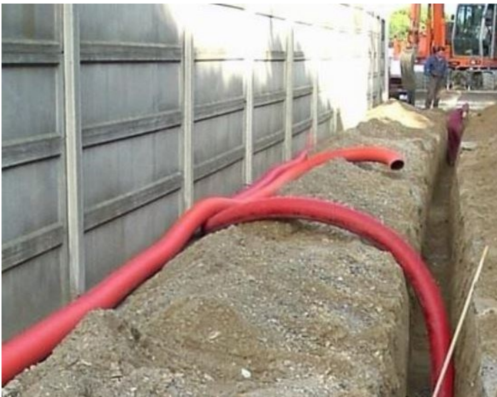
Figura 7 - scavo per elettrodotti interrati
