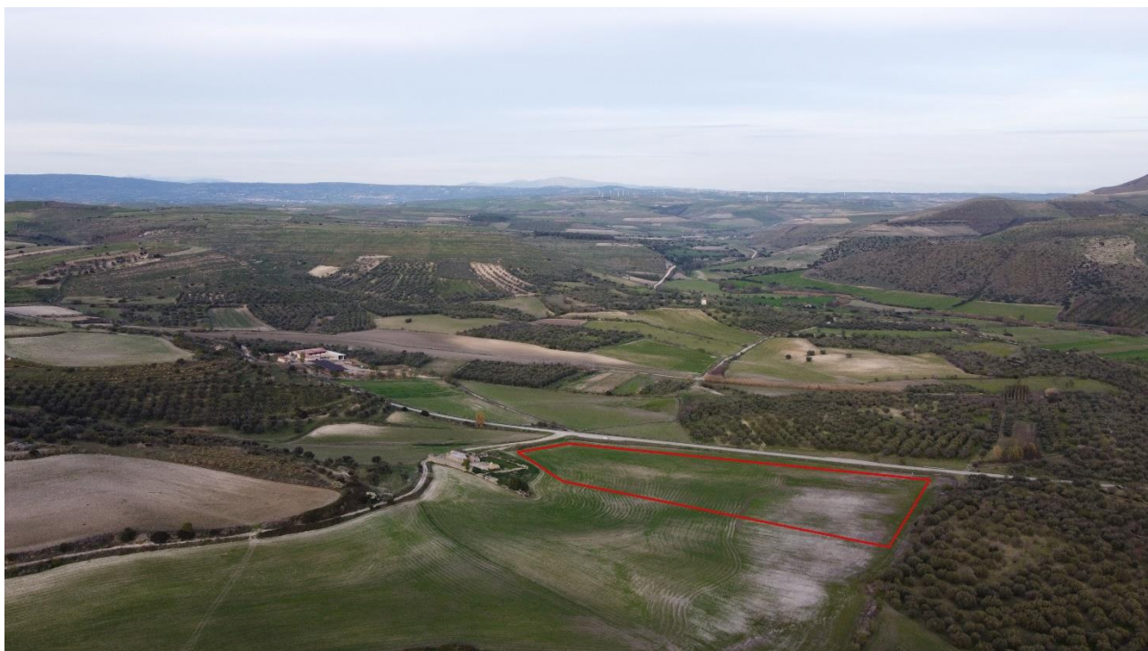
Figura 5.24 – Sito individuato per l’allestimento delle aree di trasbordo e cantiere di base in comune di Villanovafranca (vista aerea da sudovest).
