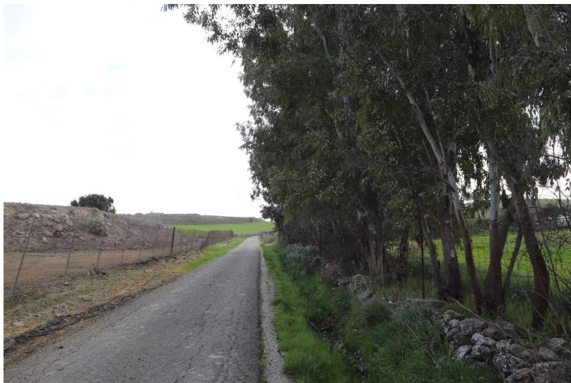
Figura 5.8 – Strada comunale Villanovafranca-Gesico oggetto di locali interventi di adeguamento (vista verso est)
