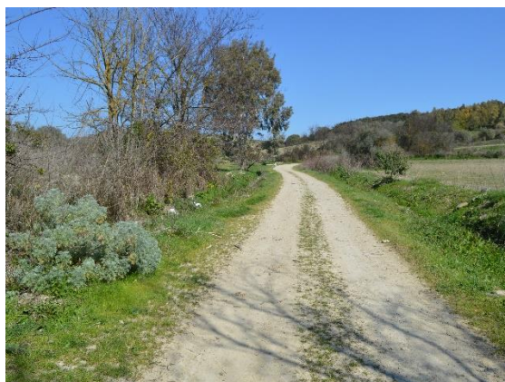
Figura 53 – Sterrato da adeguare
