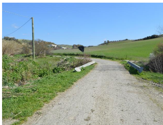
Figura 56 - Viabilità asfaltata esistente
