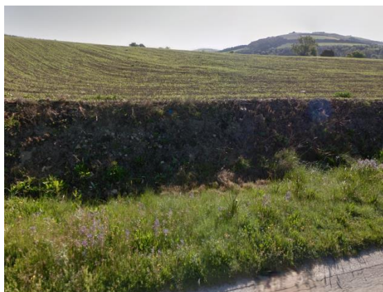
Figura 62 - Area di manovra. Vista NW → SE
