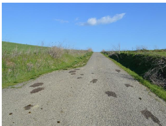
Figura 55 – Viabilità asfaltata esistente
